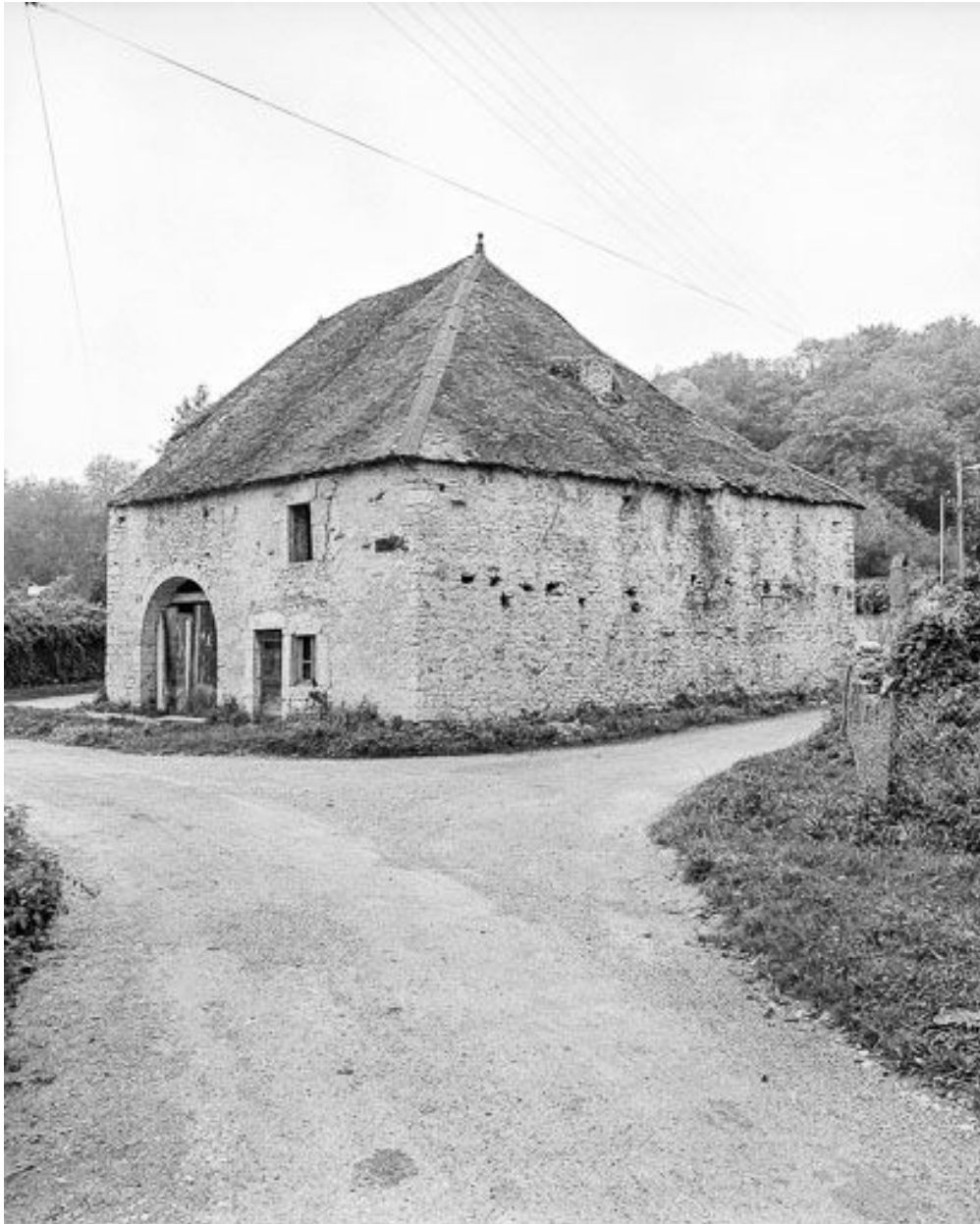
Façades antérieure et latérale droite.
