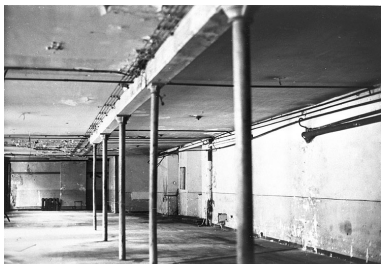
L'atelier au rez-de- chaussée (état en 1978). Phot. Jérôme Mongreville, Phot. Bernard Goetz IVR43_20029000022X
