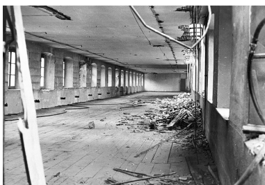
Atelier au second étage (état en 1978). Phot. Jérôme Mongreville, Phot. Bernard Goetz IVR43_20029000015X
