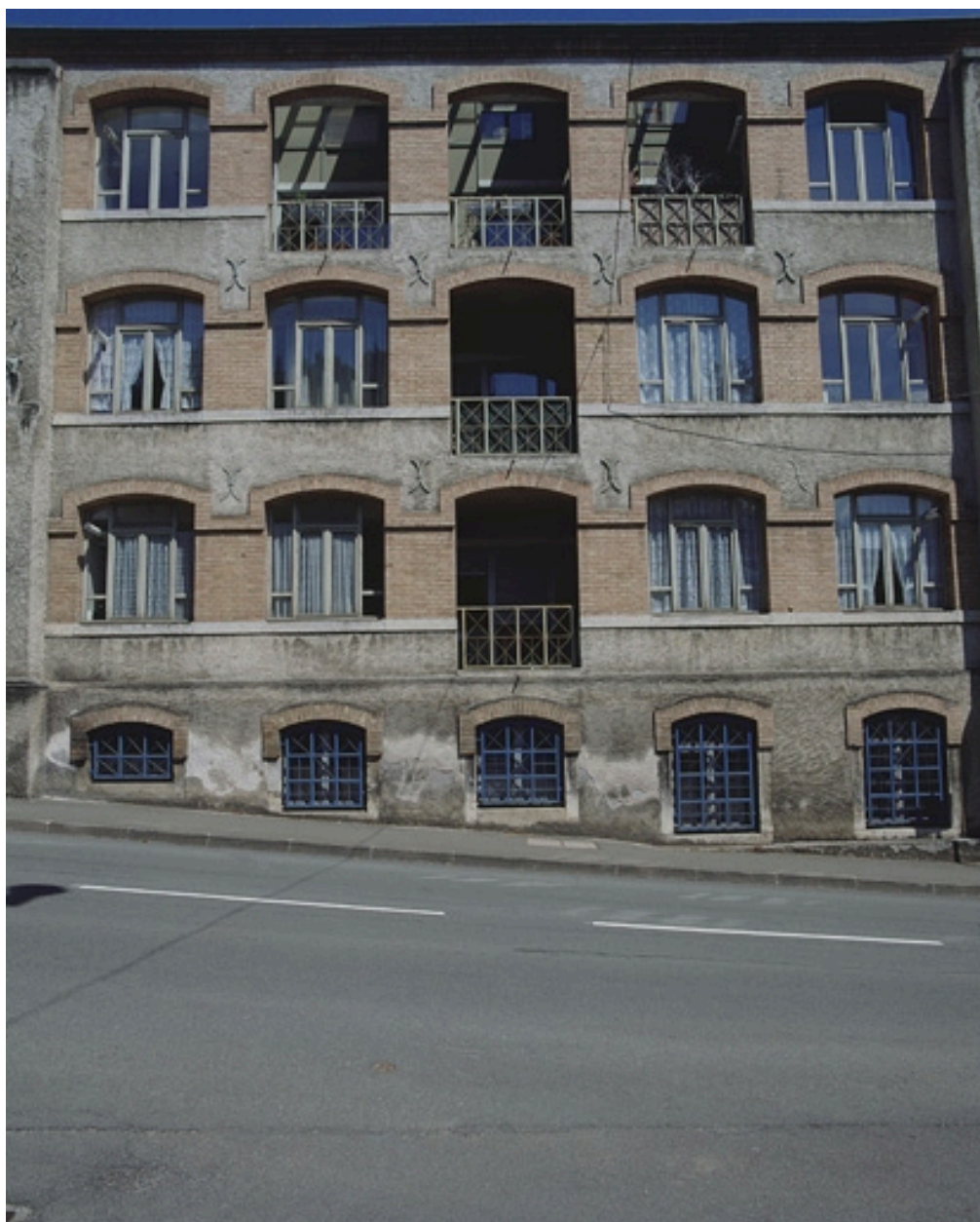
Travées de la façade antérieure.
