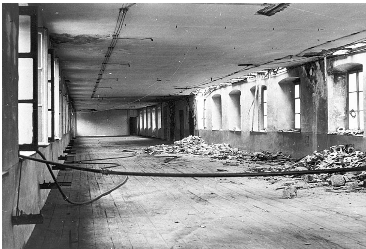
Atelier au second étage (état en 1978).
