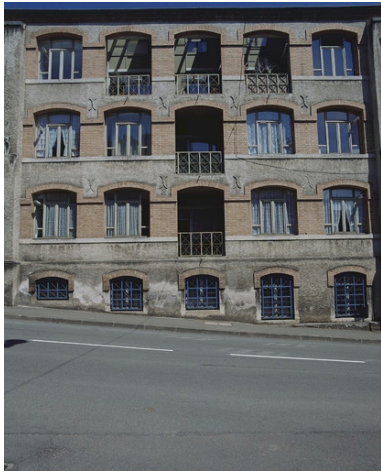
Travées de la façade antérieure.
