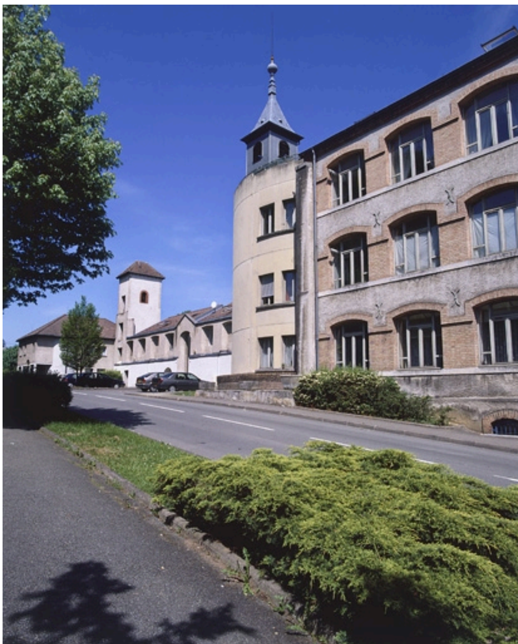
Façades sud depuis la rue Frédéric Japy.
