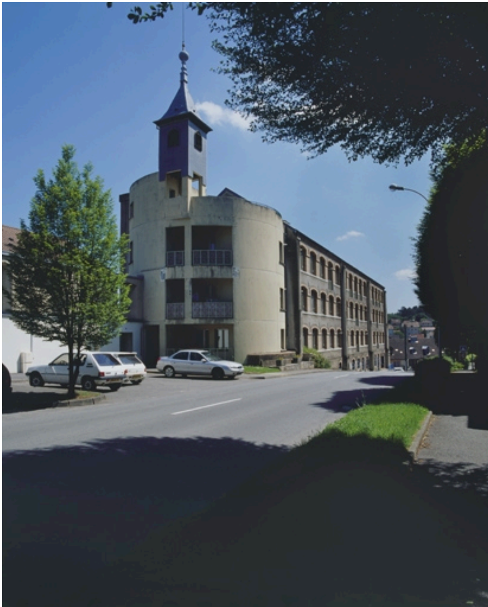
Extrémité ouest de l'atelier de fabrication.
