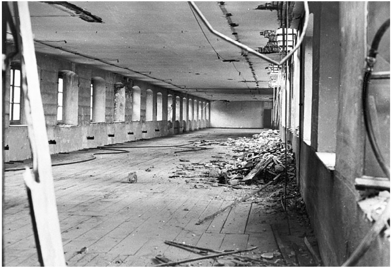
Atelier au second étage (état en 1978).
