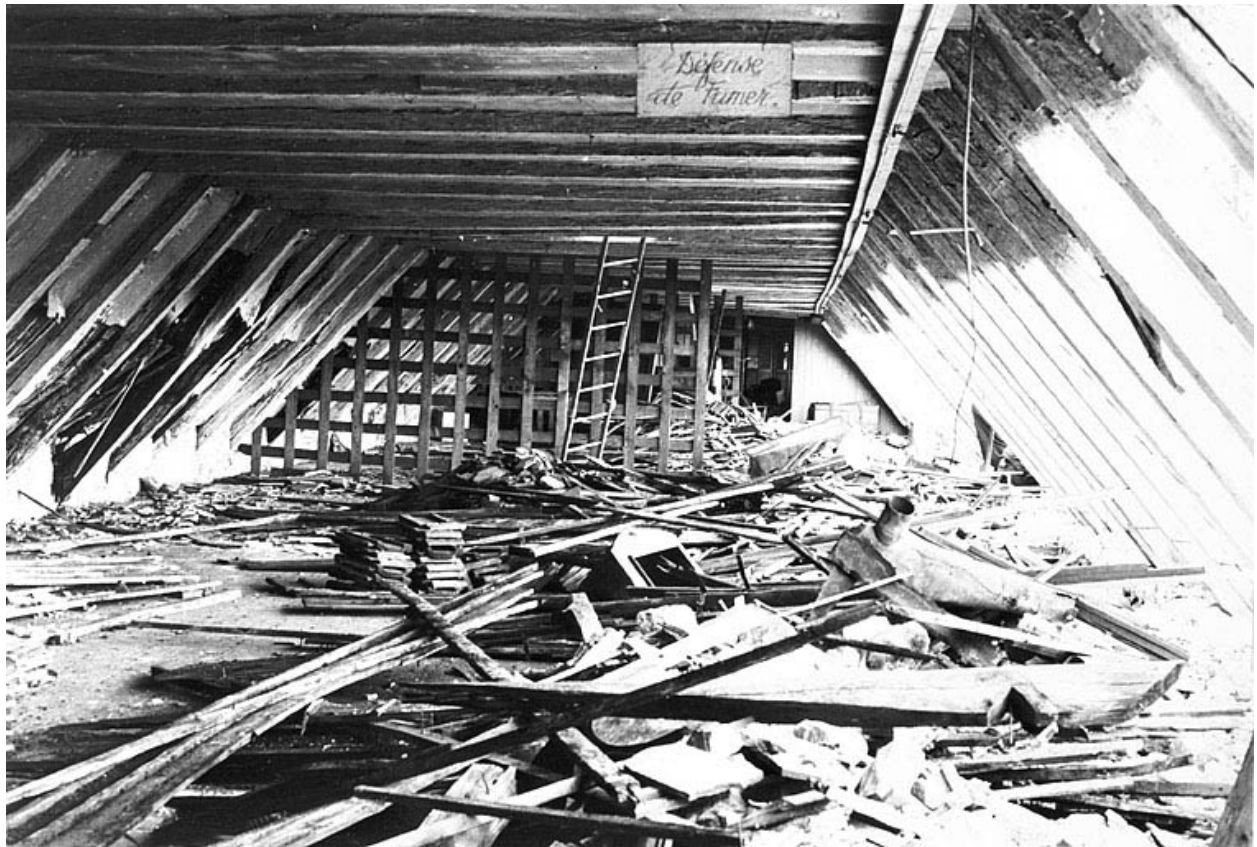
L'étage de comble (état en 1978).
