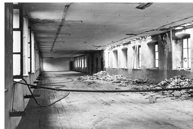
Atelier au second étage (état en 1978). Phot. Jérôme Mongreville, Phot. Bernard Goetz IVR43_20029000021X
