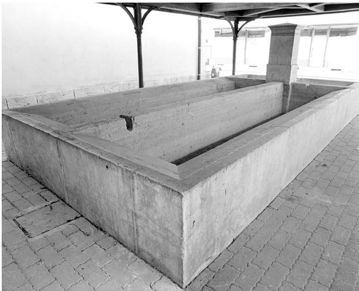
Bassin côté lavoir, vu de trois quarts.
