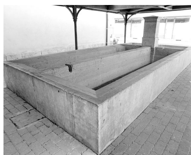
Bassin côté lavoir, vu de trois quarts. Phot. Yves Sancey IVR43 20033900197X
