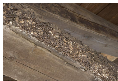
Clous sur l'une des poutres. Ces clous auraient autrefois servi à fixer le carton par lequel chaque famille réservait le lavoir pour sa grande lessive. Phot. Yves Sancey IVR43 20093900103NUC2A
