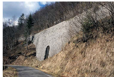
Vue d'ensemble, de trois quarts droite. Phot. Yves Sancey IVR43_20053900604ZA
