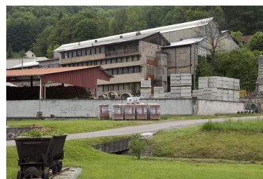
Vue d'ensemble depuis le sud-est. Phot. Jérôme Mongreville IVR43_20067000426NUCA
