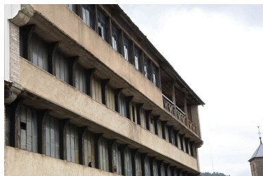
Atelier de fabrication primitif. Détail des encorbellements. Phot. Jérôme Mongreville IVR43_20067000429NUCA
