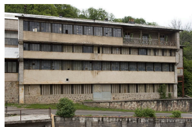
Façade sur rue de l'atelier de fabrication primitif. Phot. Jérôme Mongreville IVR43_20067000430NUCA
