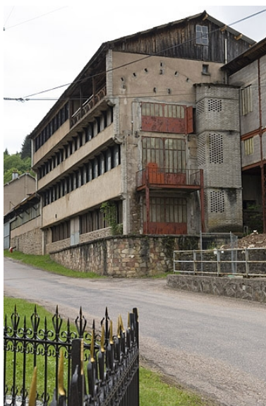
Elévation sud-est de l'atelier de fabrication primitif. Phot. Jérôme Mongreville IVR43_20067000427NUCA
