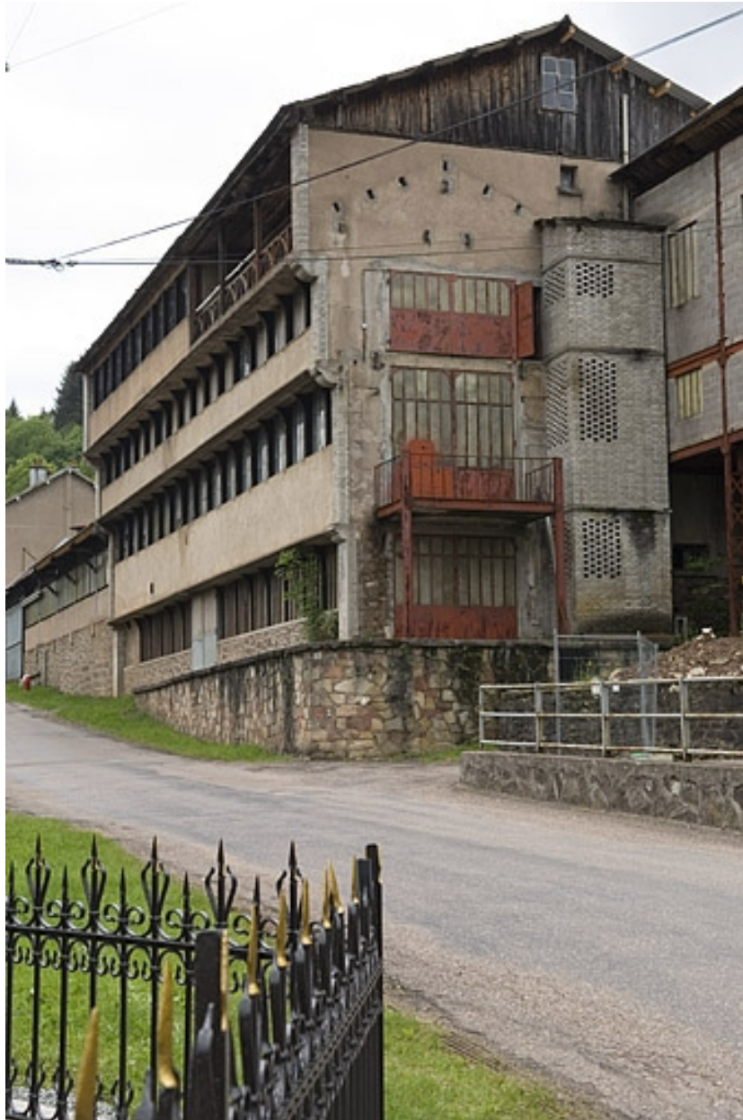
Elévation sud-est de l'atelier de fabrication primitif.
