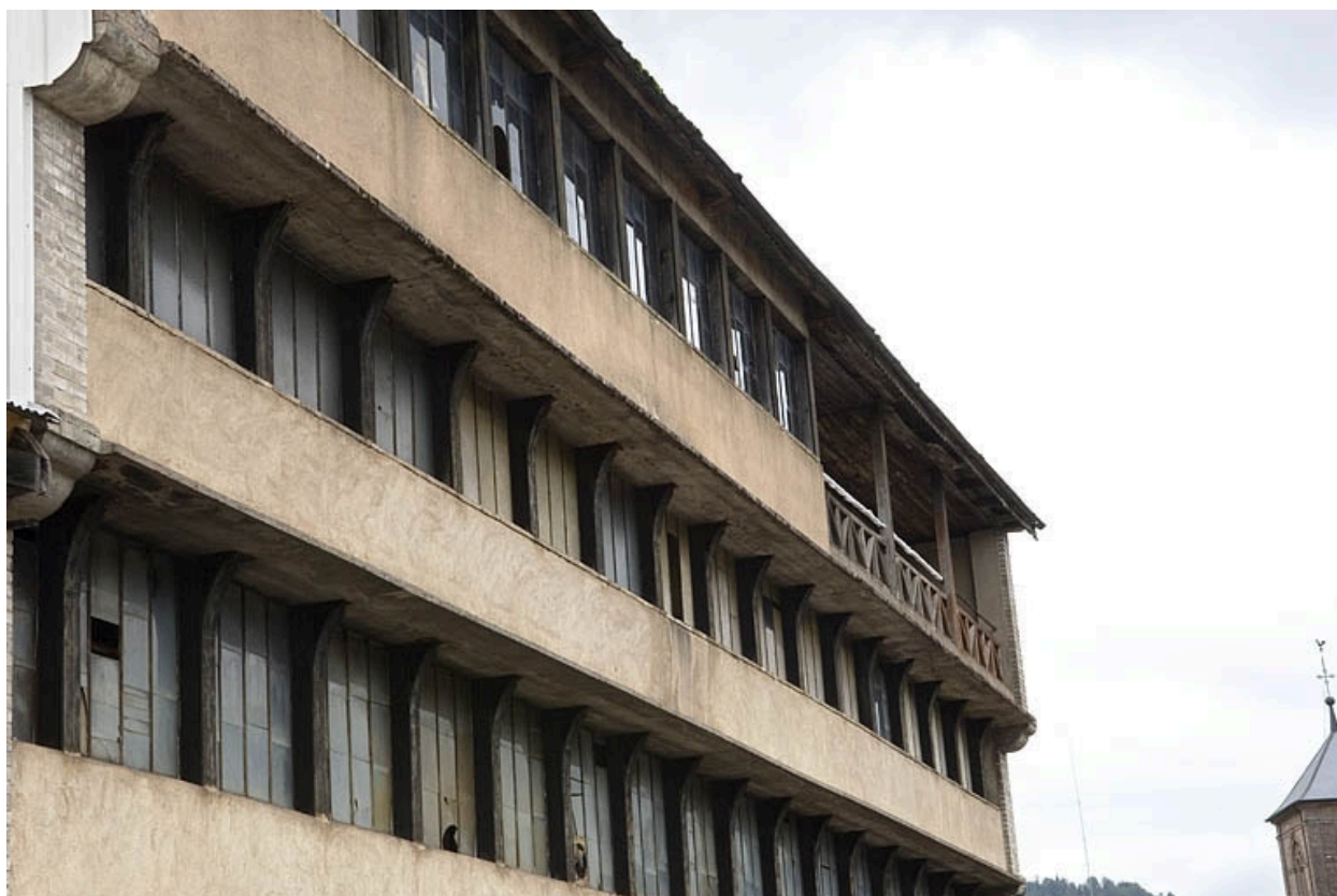
Atelier de fabrication primitif. Détail des encorbellements.
