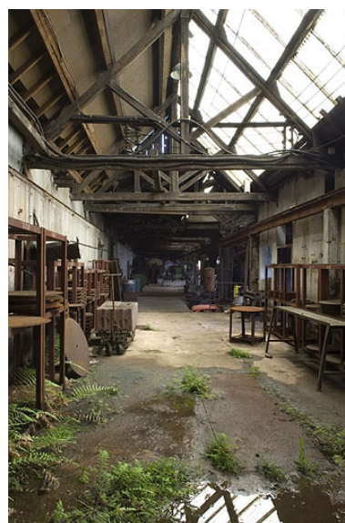
Extension occidentale de l'atelier de fabrication. Vue intérieure. Phot. Jérôme Mongreville IVR43_20067000434NUCA
