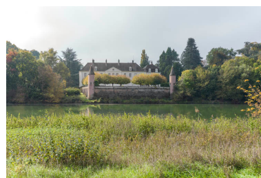
Le château de Pouilly et sa terrasse vus depuis le chemin de halage, rive gauche de la Saône. Phot. Thierry Kuntz IVR26_20172100499NUC4A
