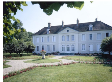
Façade sur Saône. Phot. Michel Rosso IVR26_19872100673VA
