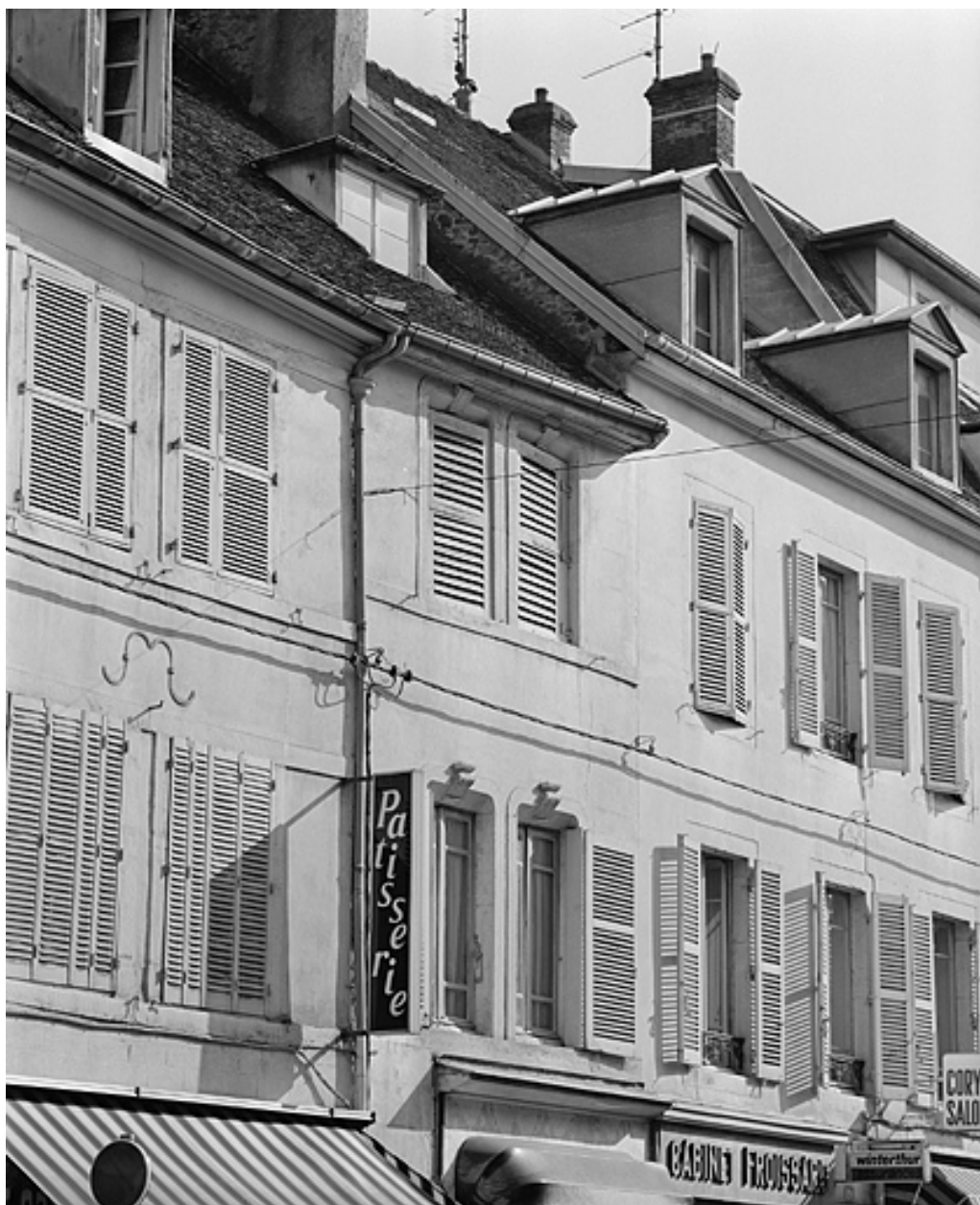
Façade antérieure, premier et deuxième étages.
