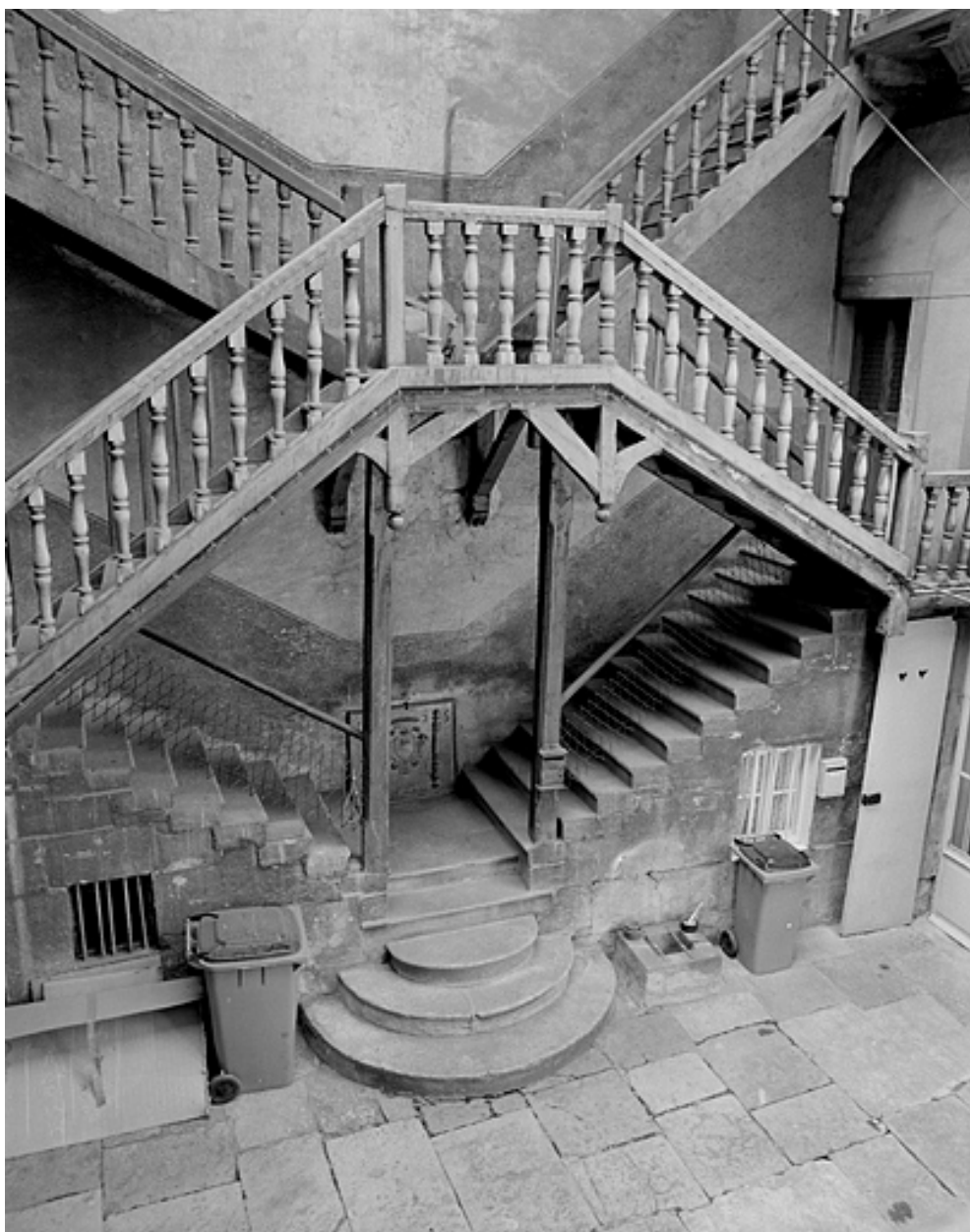
Escalier dans la cour.
