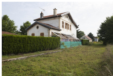
Façade postérieure. Phot. Jérôme Mongreville IVR43_20127000630NUC4A
