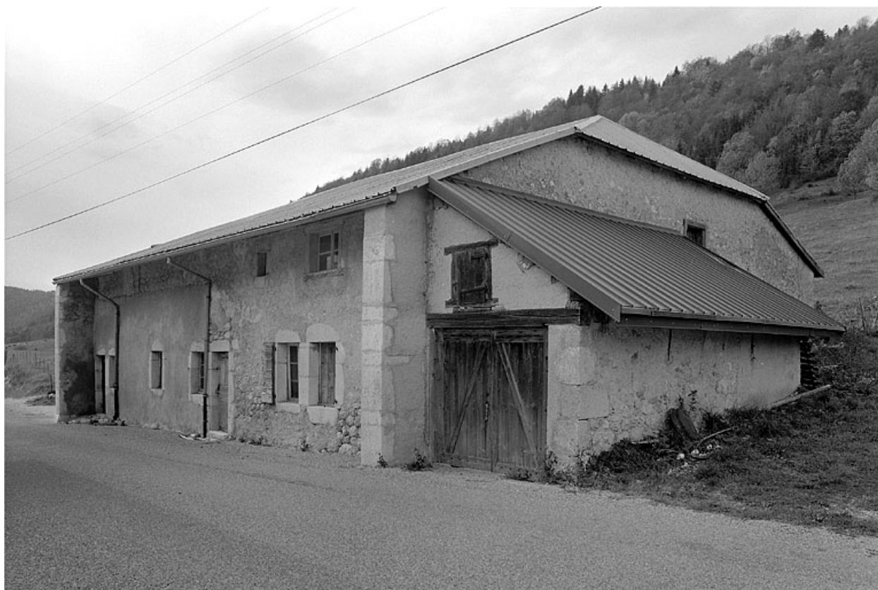
Façade antérieure et face nord-est.
