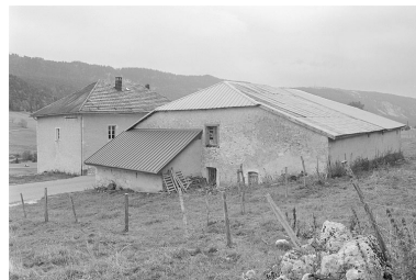
Façade postérieure et face nord-est. Phot. Jérôme Mongreville IVR43_19963901531X
