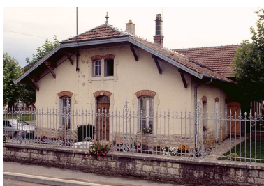
Mur-pignon et façade postérieure depuis l'ouest. Phot. Jérôme Mongreville IVR43_19953900450ZA
