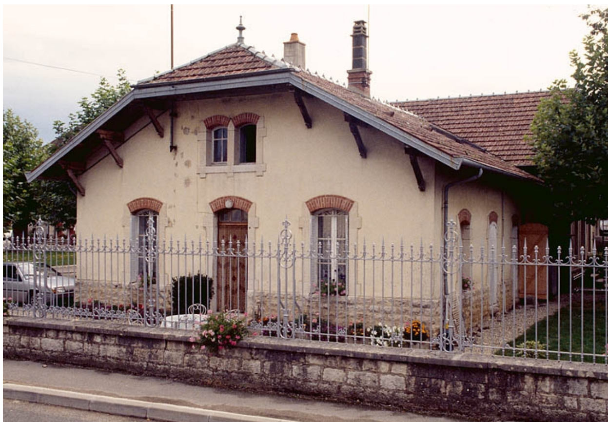
Mur-pignon et façade postérieure depuis l'ouest.
