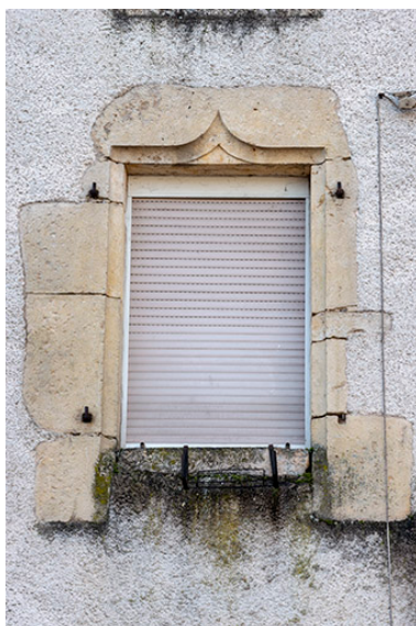
Fenêtre avec linteau en accolade. Phot. Jérôme Mongreville IVR43_20197000120NUC4A
