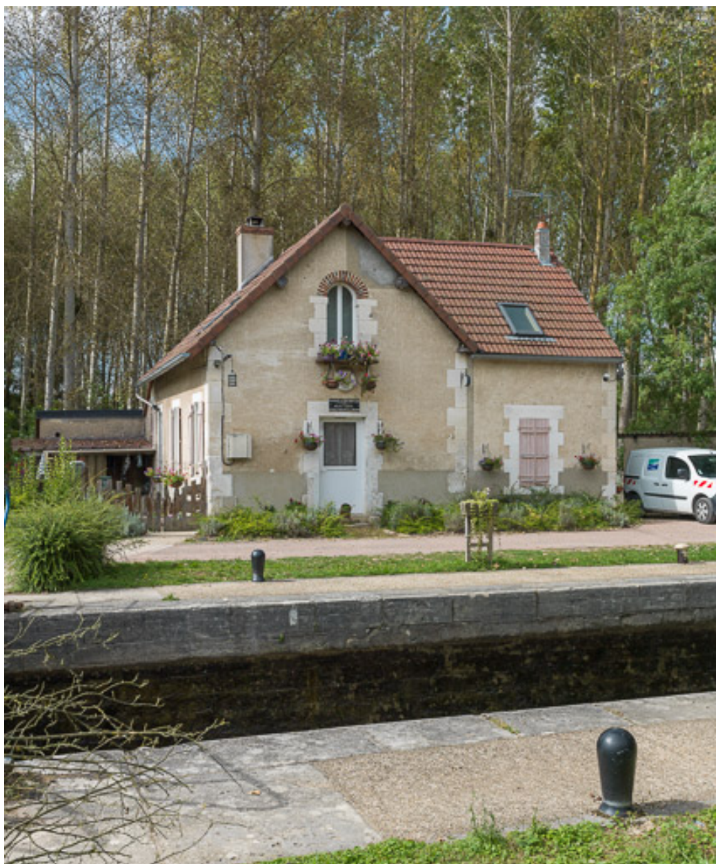
Vue de la maison éclusière.
