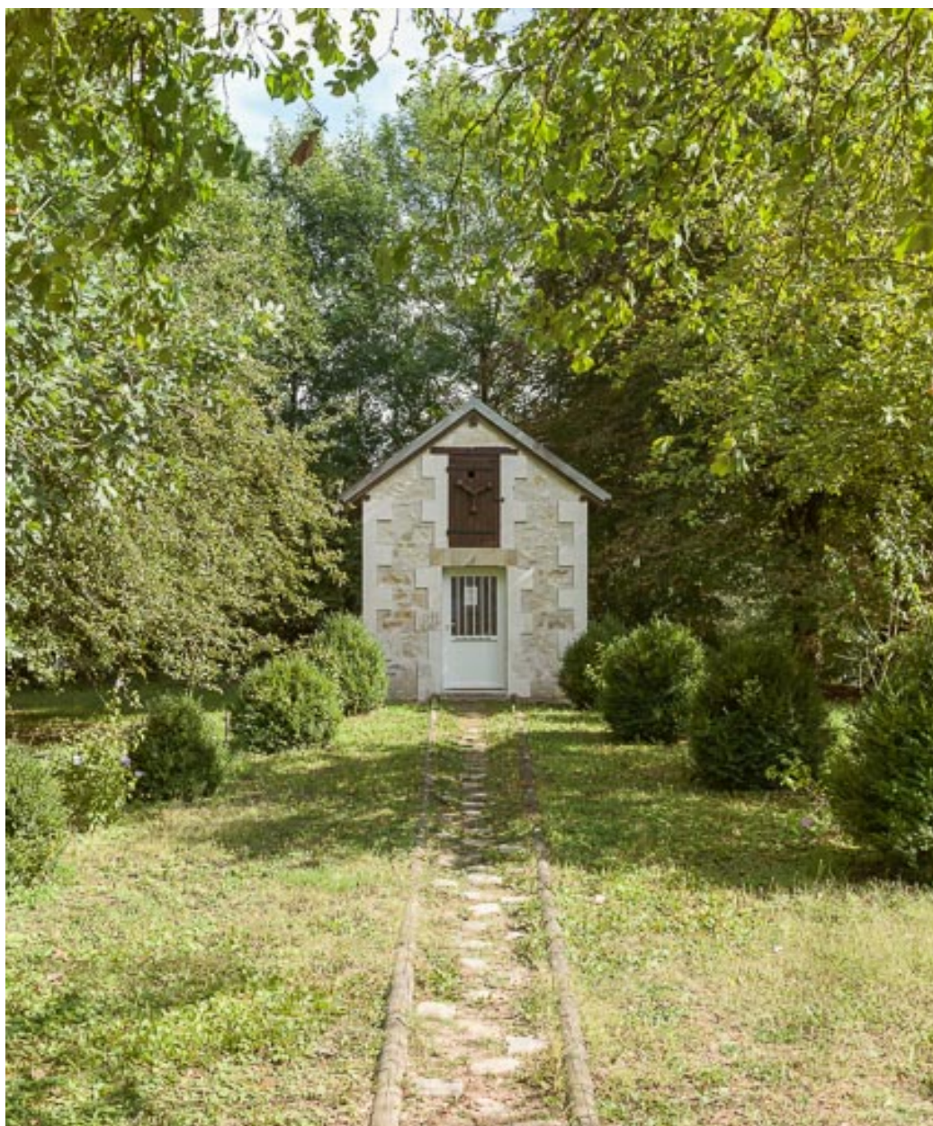
Vue de l'annexe agricole.
