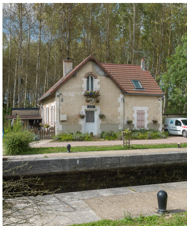
Vue de la maison éclusière. Phot. Pierre-Marie Barbe-Richaud IVR26_20178900187NUC2A
