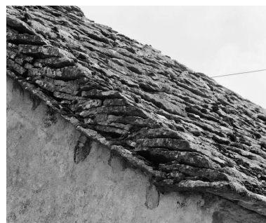
Détail du toit. Phot. Jean-Luc Duthu IVR26_19792100761X
