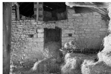
Porte d'enfournement du 2e four (four intérieur). Phot. Laurent Poupard IVR43_19883900535Z
