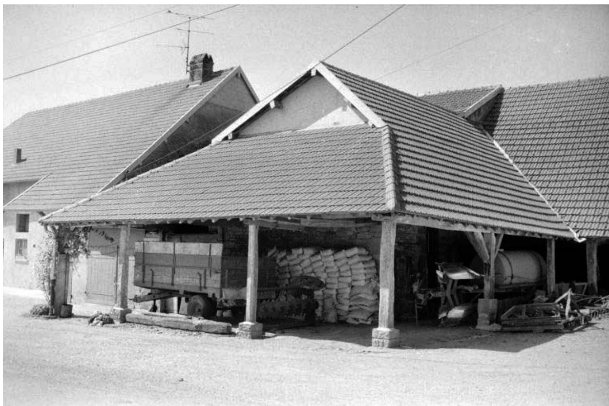
Corps de bâtiment abritant le 1er four.
