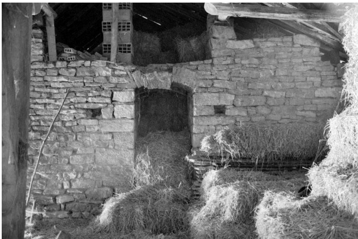
Porte d'enfournement du 2e four (four intérieur).
