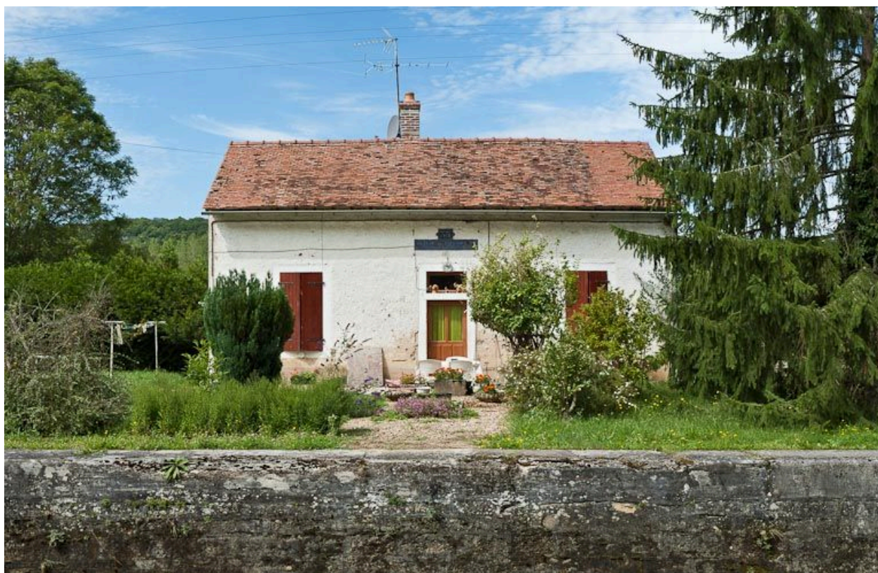
Vue de face de la maison éclusière.
