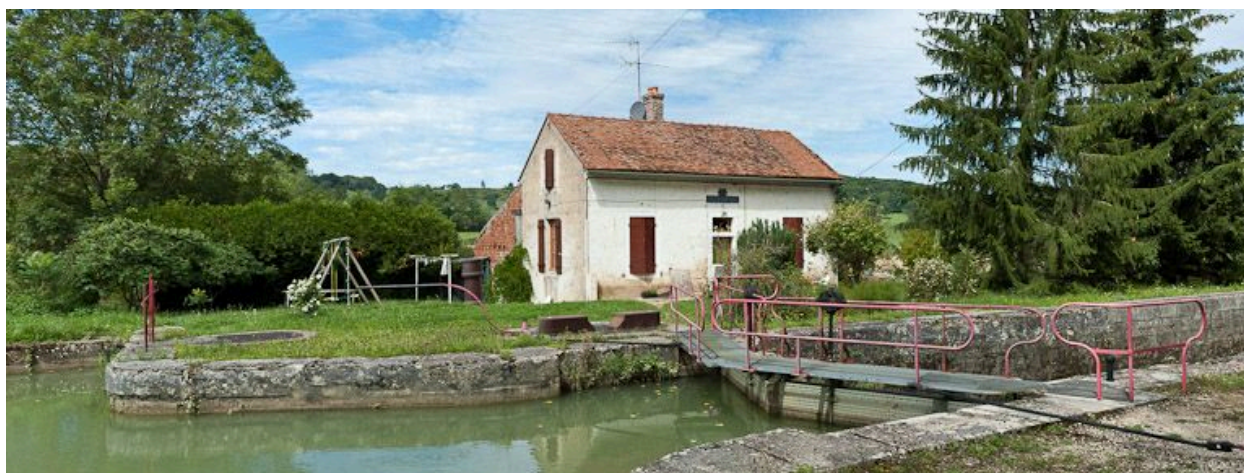
Vue d'ensemble du site d'écluse.
