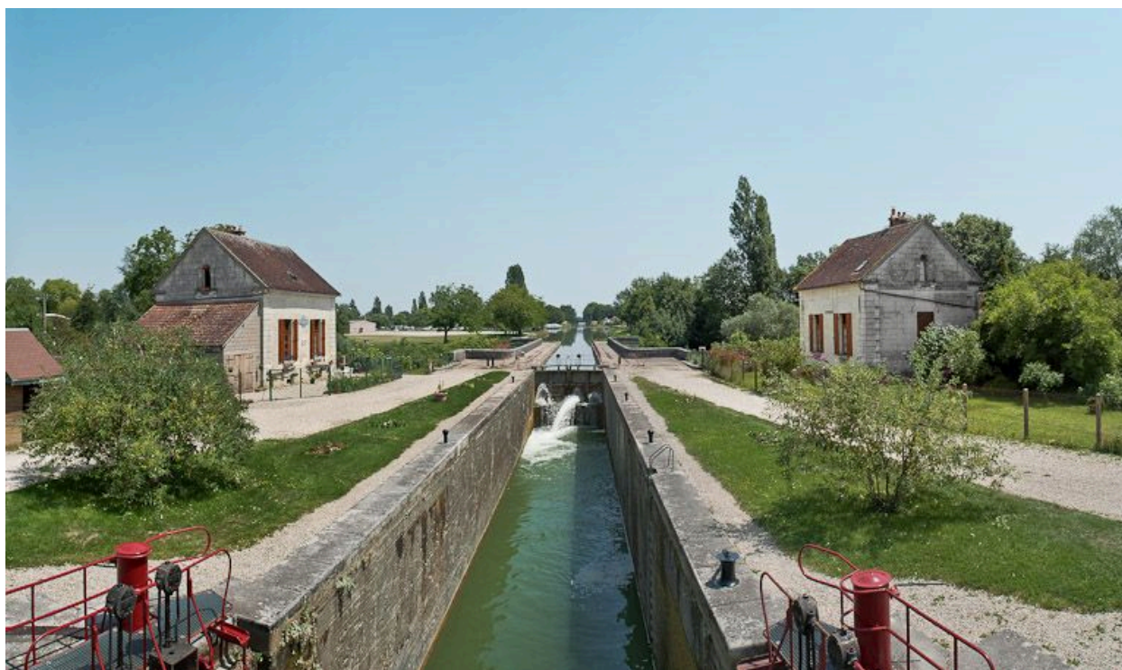
Vue d'ensemble du site d'écluse.
