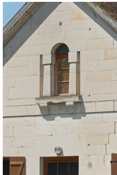
Détail de la maison éclusière. Phot. Pierre-Marie Barbe-Richaud IVR26_20118900381NUC2AQ
