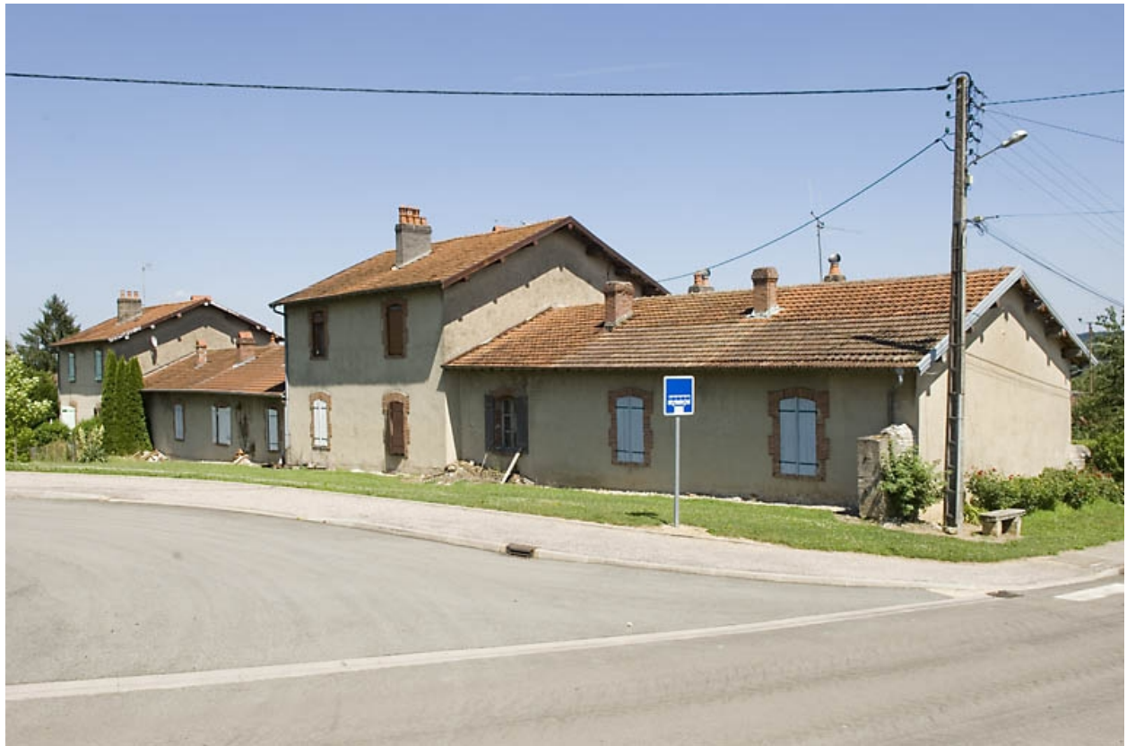
Logements ouvriers contigus. Vue depuis le sud.
