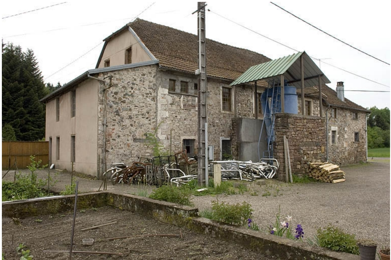
Façade nord de l'atelier de filature.
