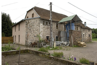
Façade nord de l'atelier de filature.
