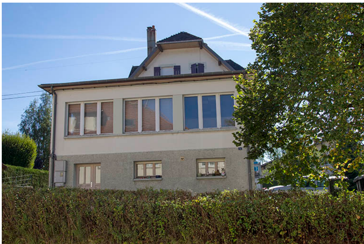
Usine : façade latérale gauche.
