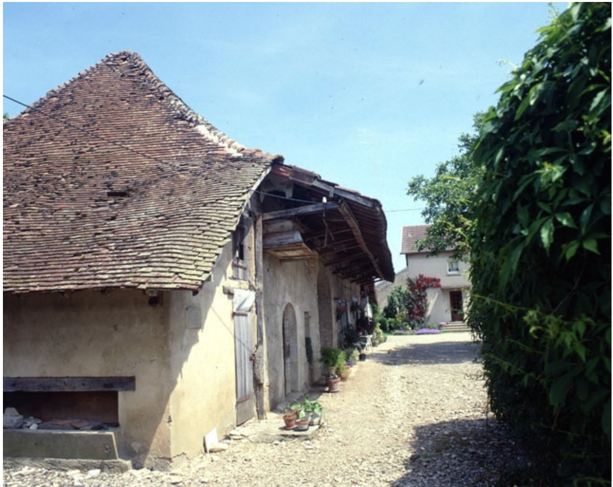
Façade antérieure en 1990 : vue de trois-quarts gauche.
