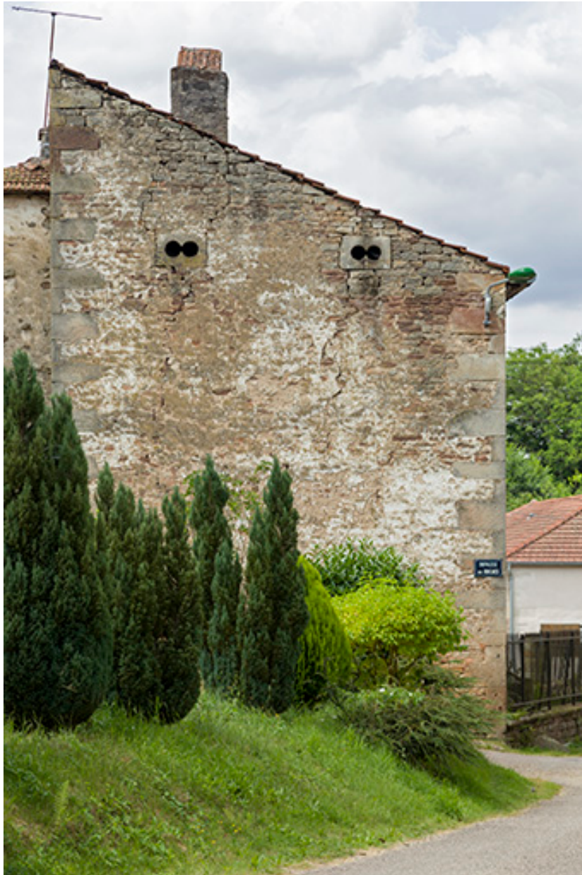
Mur pignon avec ses petits oculis.
