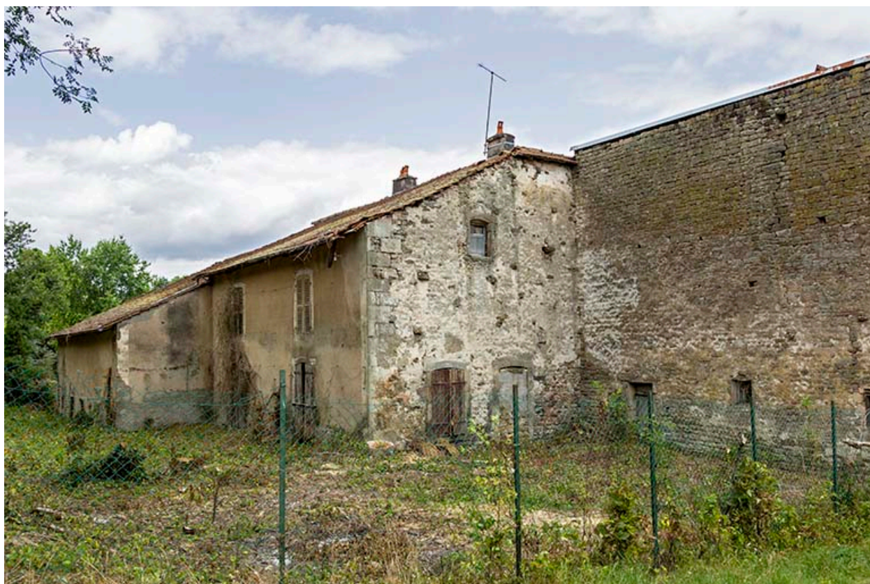
Vue générale sur la façade postérieure.
