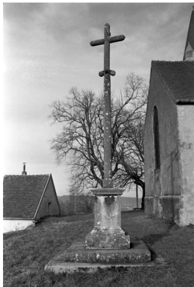
Vue générale. Phot. Guy Forestier IVR43_19743900436Z
