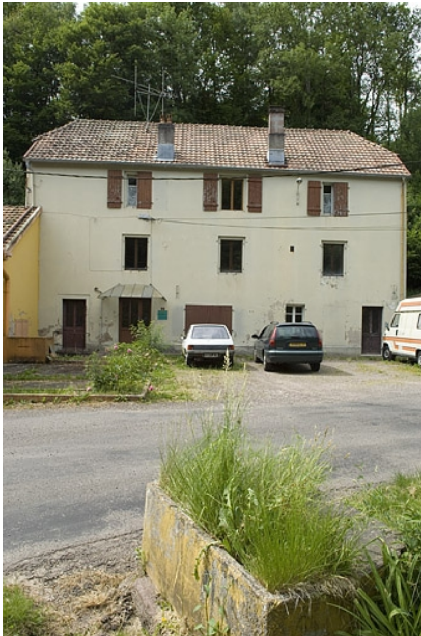
Façade antérieure de l'ancienne saboterie.
