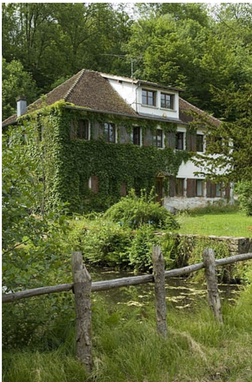
Ancienne saboterie, actuellement logement.
