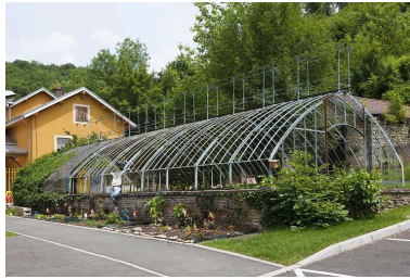
La serre. Phot. Jérôme Mongreville IVR43_20112501316NUC4A
