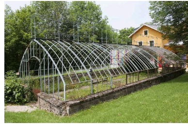
Serre et communs depuis le sud-est. Phot. Jérôme Mongreville IVR43_20112501318NUC4A
