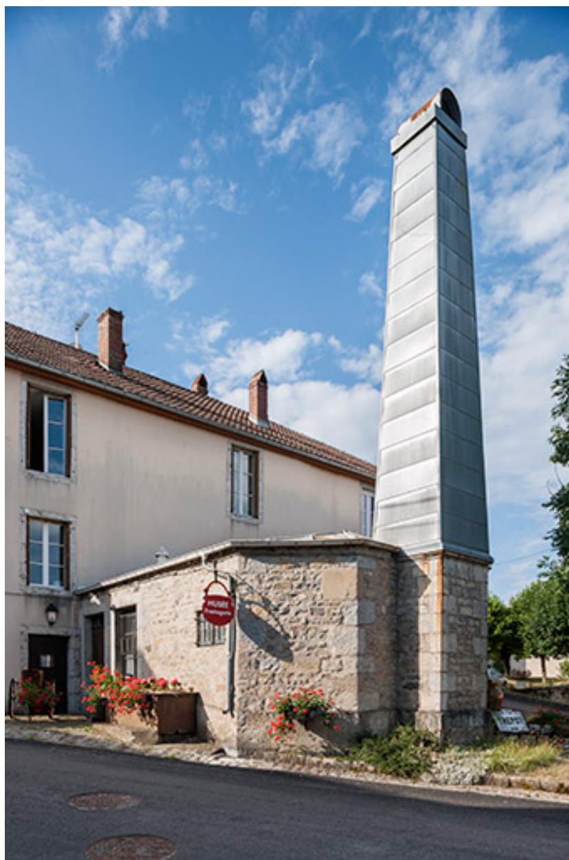
Bâtiment de la fromagerie depuis le nord-est.
