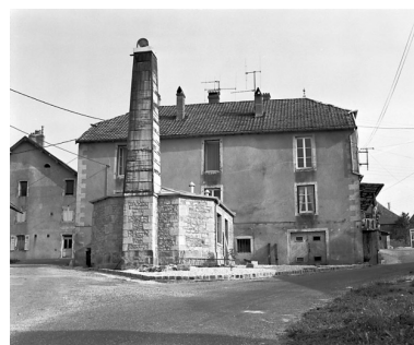
Façade postérieure du bâtiment en 1980. Phot. Yves Sancey IVR43_19802501192X
