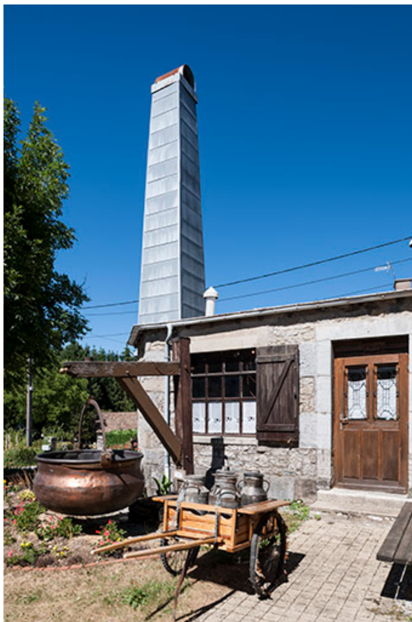
Façade ouest de l'atelier de la fromagerie.
