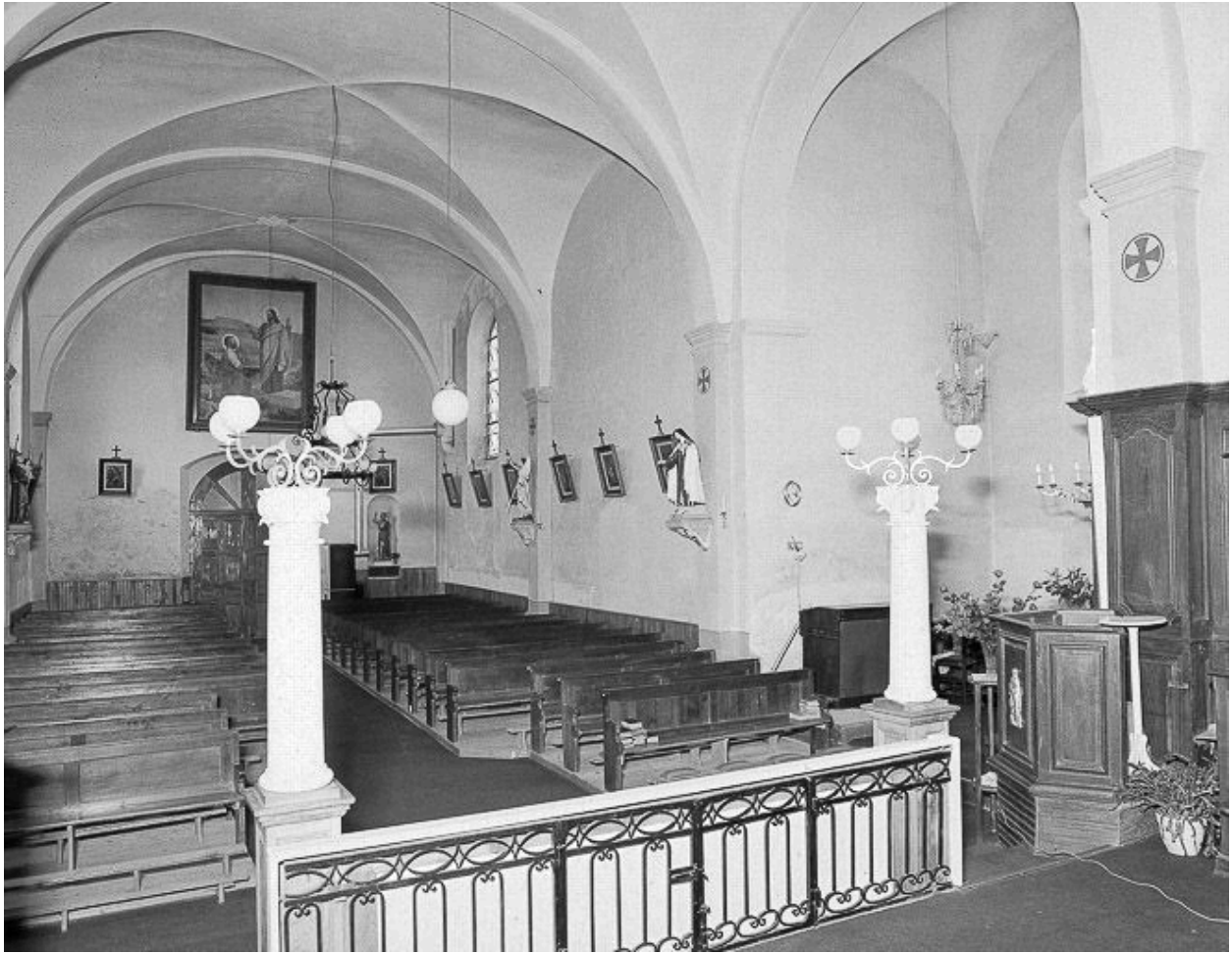
Nef, élévation gauche vue du choeur.
