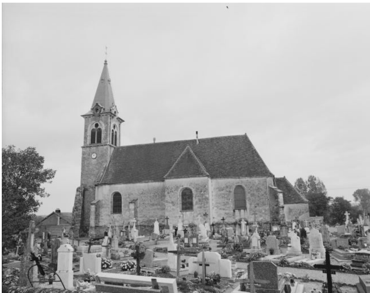
Façade latérale droite.
