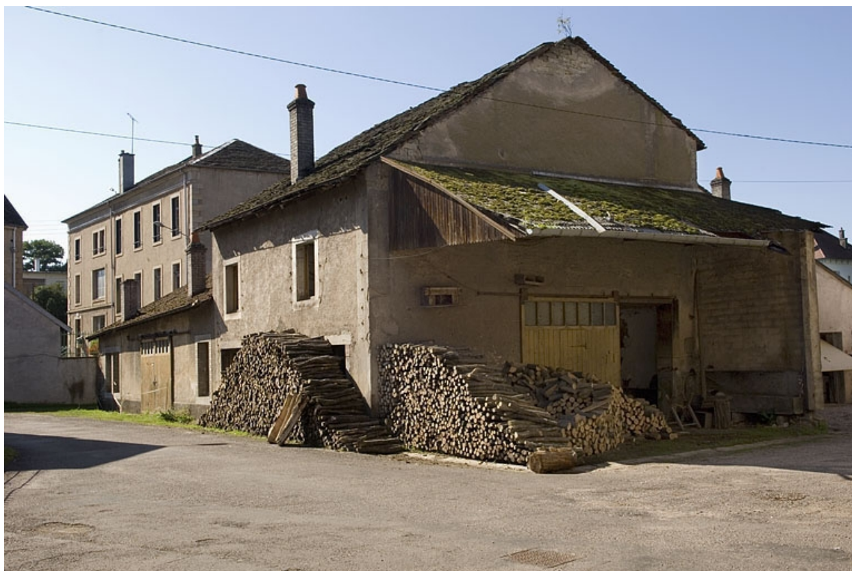
Atelier de fabrication sud.
