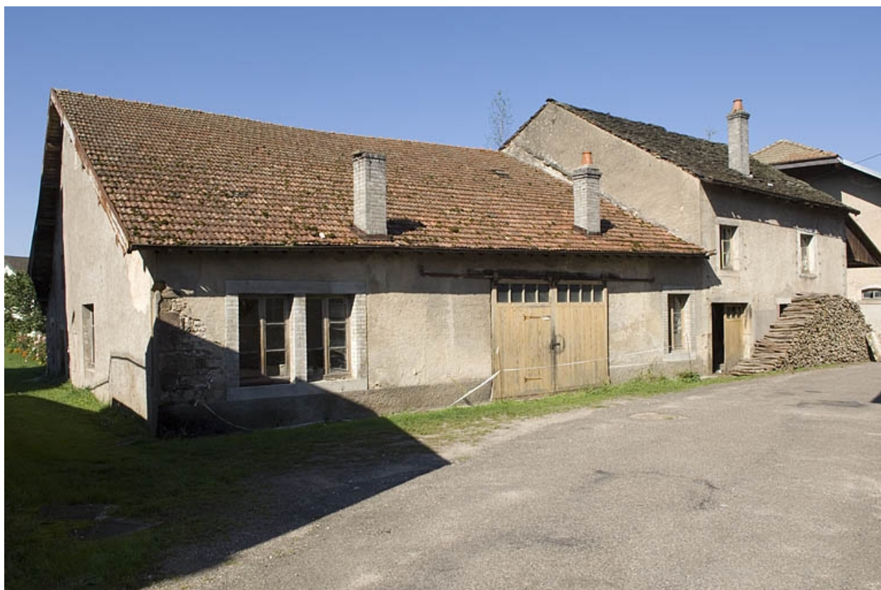
Atelier de fabrication sud. Vue depuis l'entrée.
