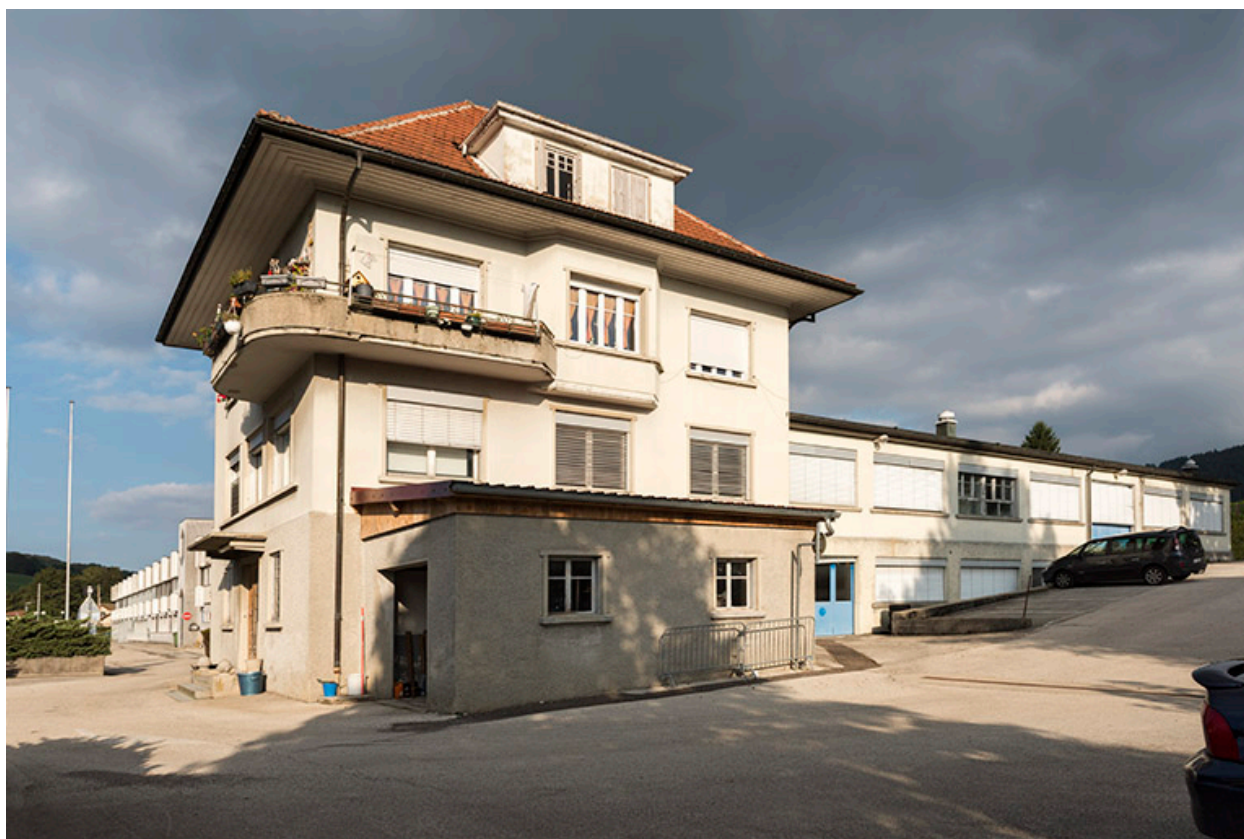
Logement-conciergerie et atelier de fabrication d'origine.
