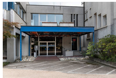
Hall d'entrée. Phot. Sonia Dourlot IVR43_20162501217NUC4A
