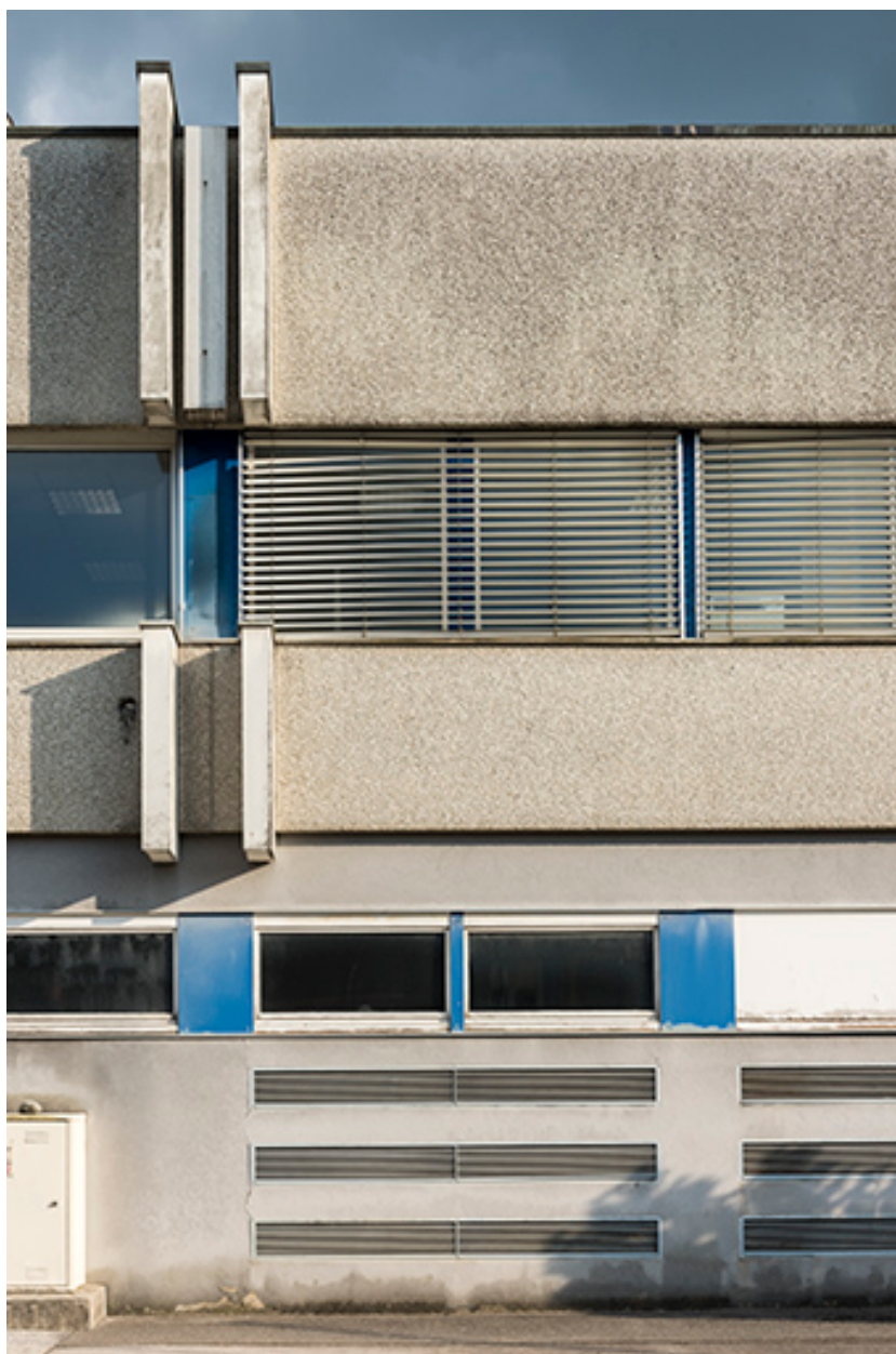
Façade ouest : une travée de l'atelier de 1970.
