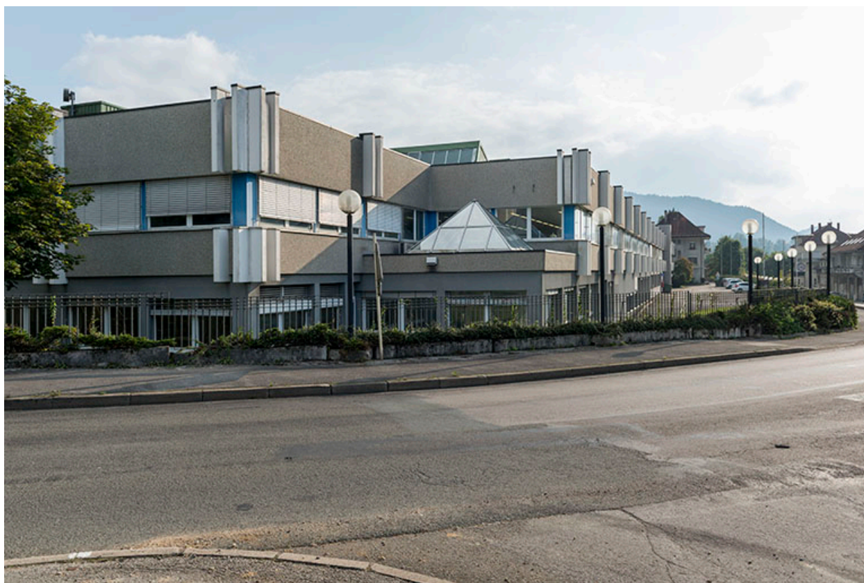
Façades nord et ouest.
