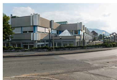
Façades nord et ouest. Phot. Sonia Dourlot IVR43_20162501208NUC4A
