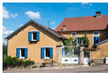
Ancien presbytère, rue du Vaux. Phot. Jérôme Mongreville IVR43_20177001306NUC4A
