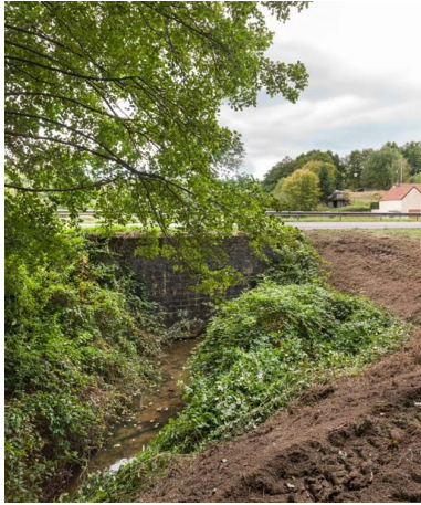
Vue de l'aqueduc.
