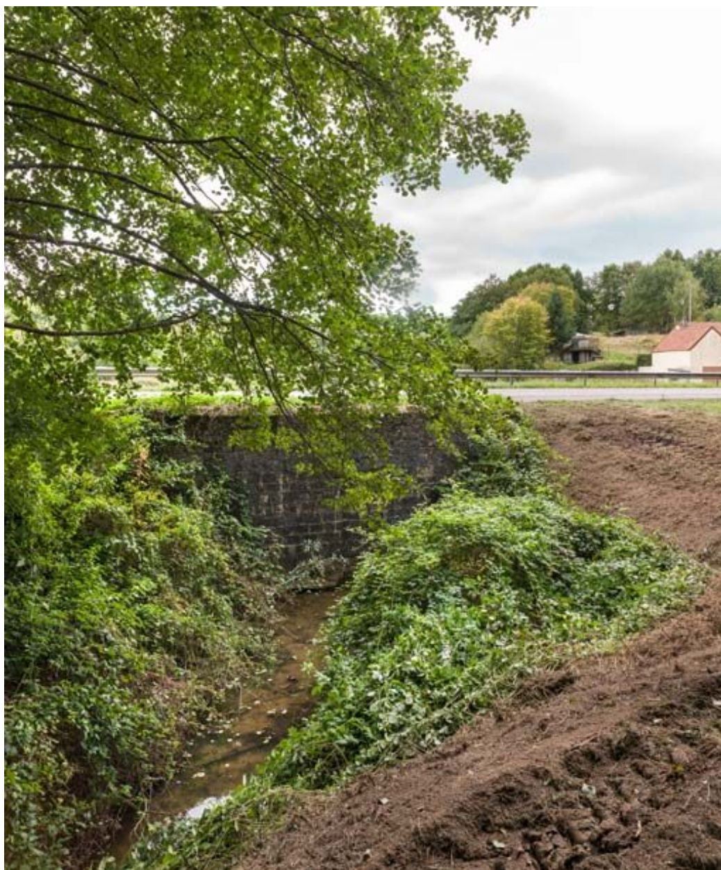
Vue de l'aqueduc.
