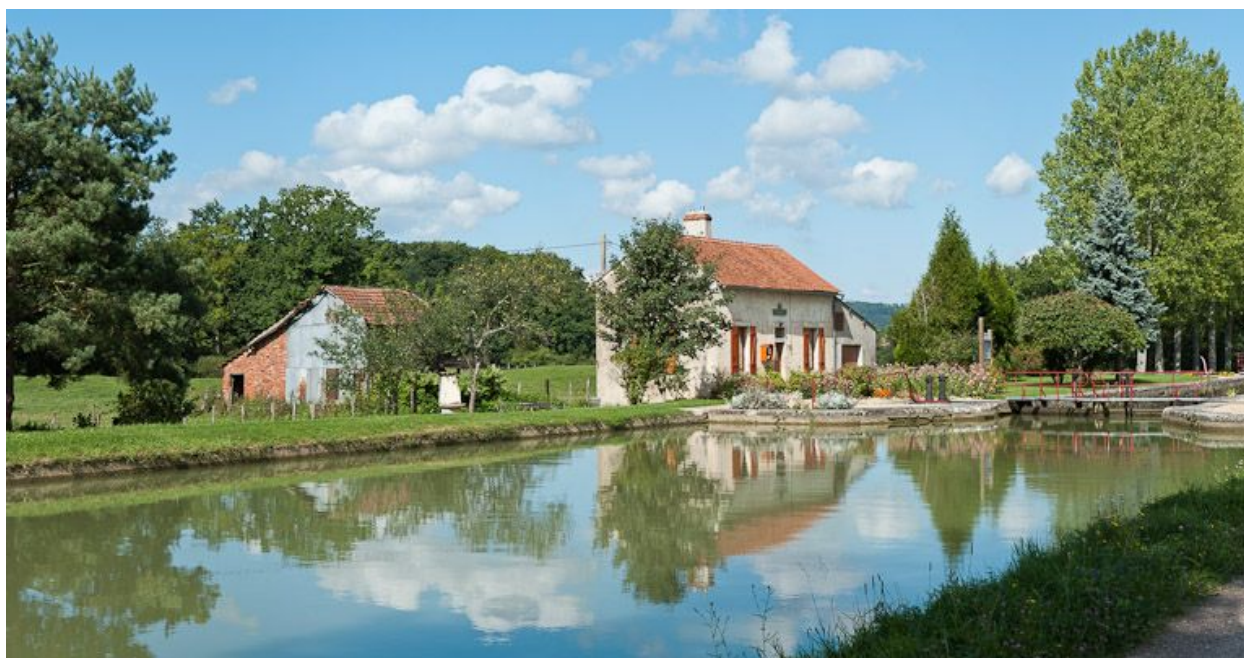
Vue du site d'écluse depuis l'amont.
