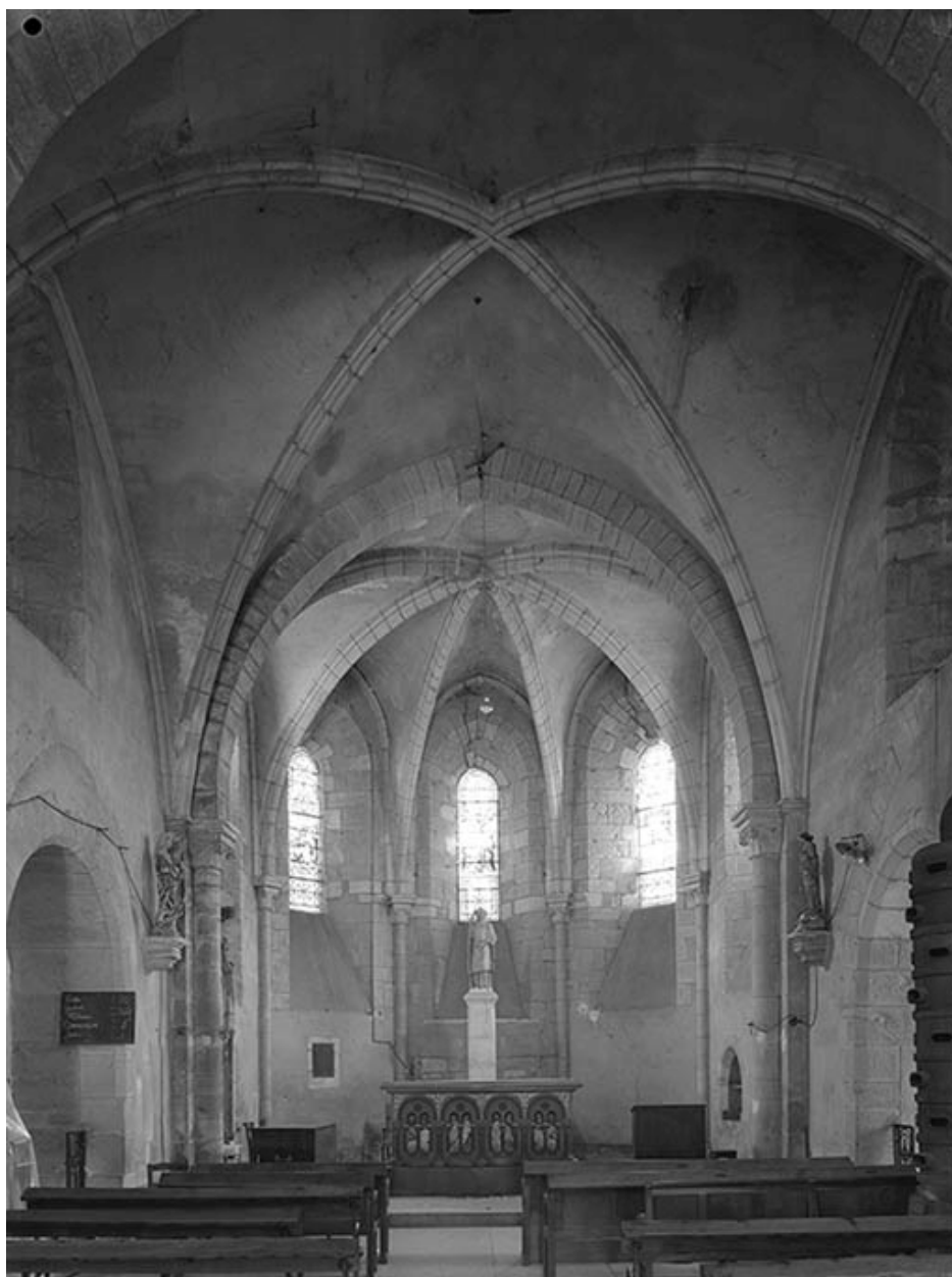
Vue intérieure vers le chœur, voûte d'ogives.
