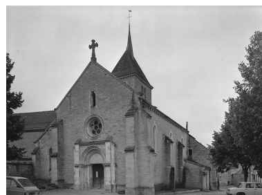
Façade occidentale avec portail. Phot. Michel Thierry IVR26_19748900587V
