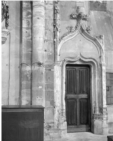
Porte ornée d'accolades et pinacles. Phot. Michel Thierry IVR26_19748900590X
