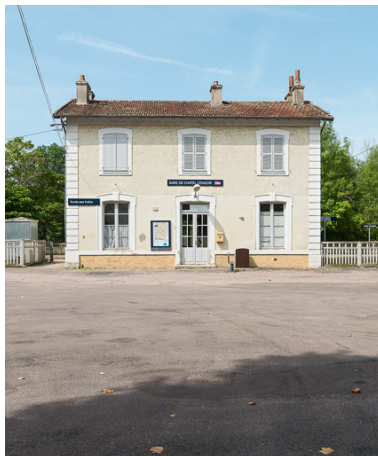
Vue de la gare.
