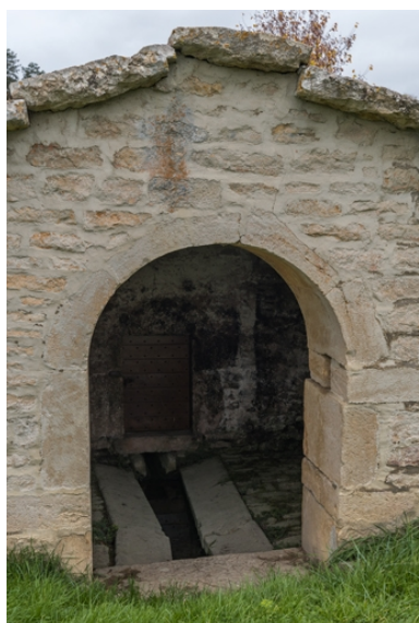
Détail de la façade est. Phot. Pierre-Marie Barbe-Richaud IVR26_20222101134NUC4A
