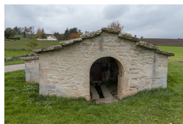
Vue de la façade est. Phot. Pierre-Marie Barbe-Richaud IVR26_20222101135NUC4A
