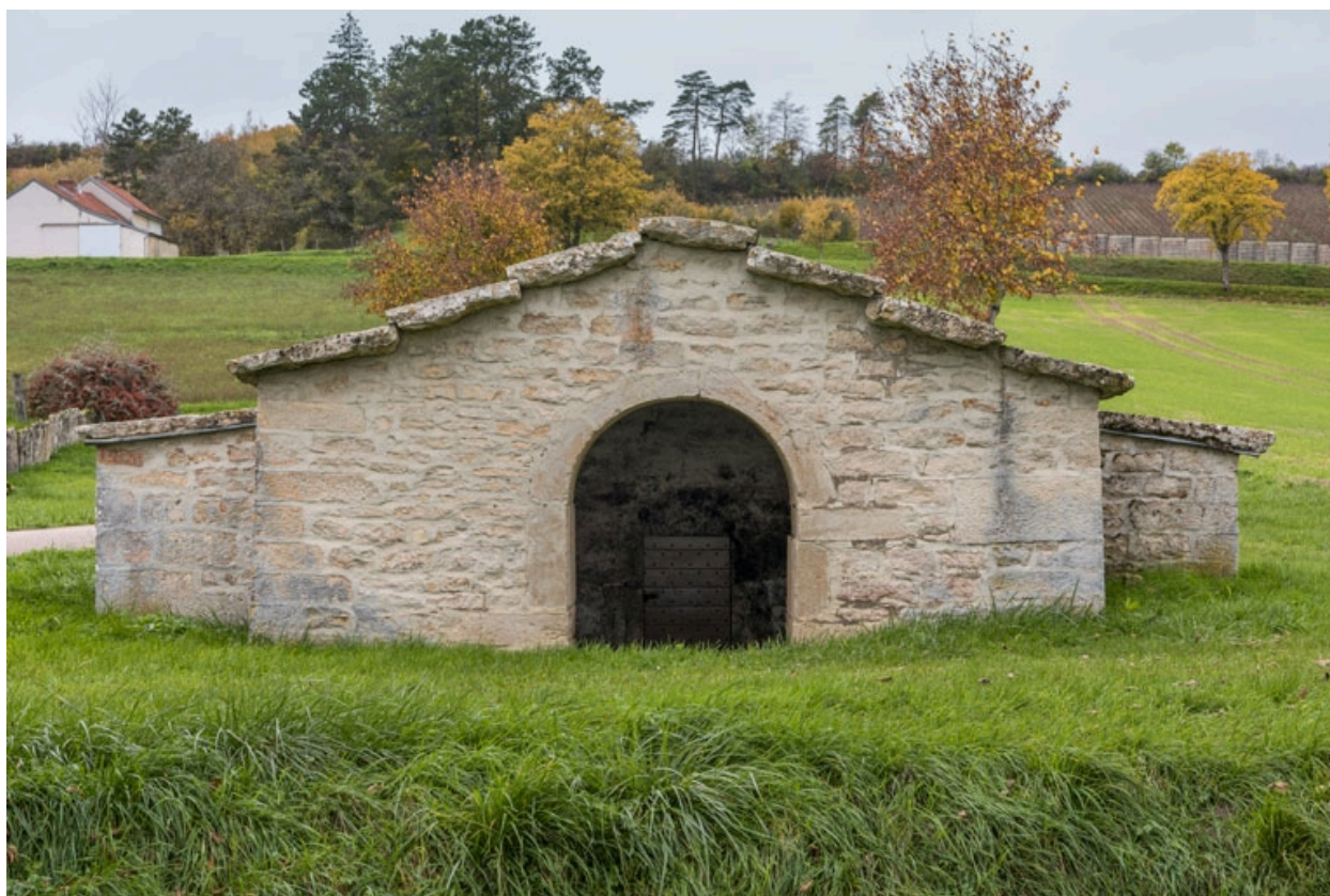
Vue de la façade est.
