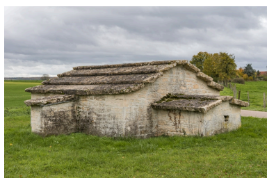
Vue d'ensemble depuis le nord-est. Phot. Pierre-Marie Barbe-Richaud IVR26_20222101132NUC4A
