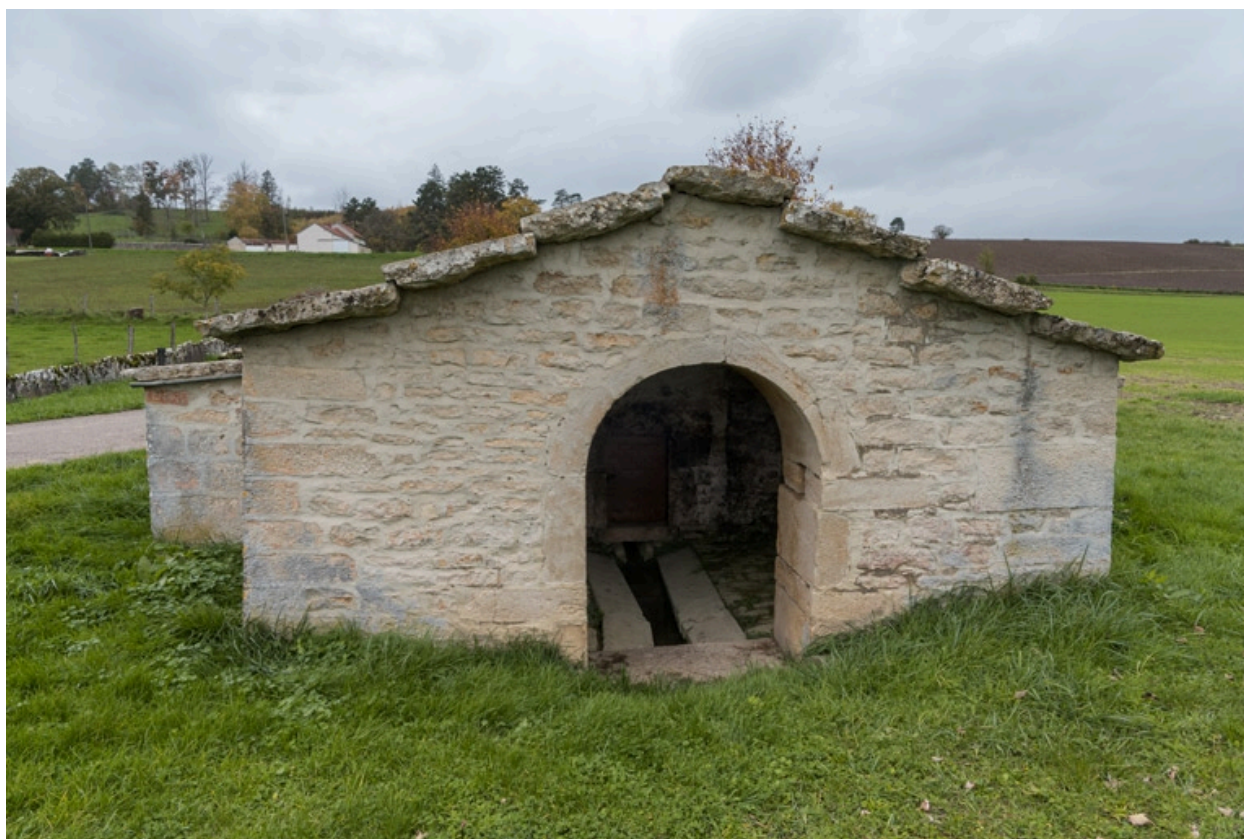
Vue de la façade est.
