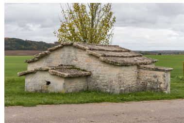
Vue d'ensemble depuis le nord-ouest. Phot. Pierre-Marie Barbe-Richaud IVR26_20222101131NUC4A
