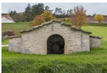
Vue de la façade est. Phot. Pierre-Marie Barbe-Richaud IVR26_20222101133NUC4A
