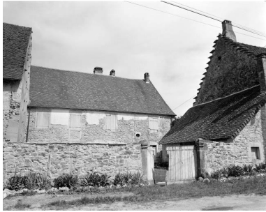
Vue générale. Phot. Bernard Lardière IVR43_19793900336X
