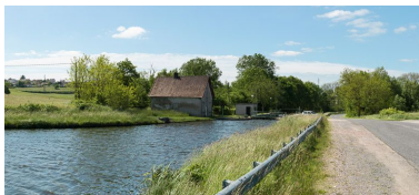
Le site, vu d'amont. Phot. Pierre-Marie Barbe-Richaud IVR26_20137100385NUC4AQ
