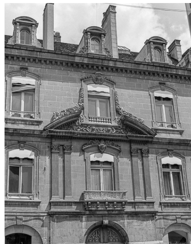
Détail du corps central. Phot. Yves Sancey IVR43_19802500202X
