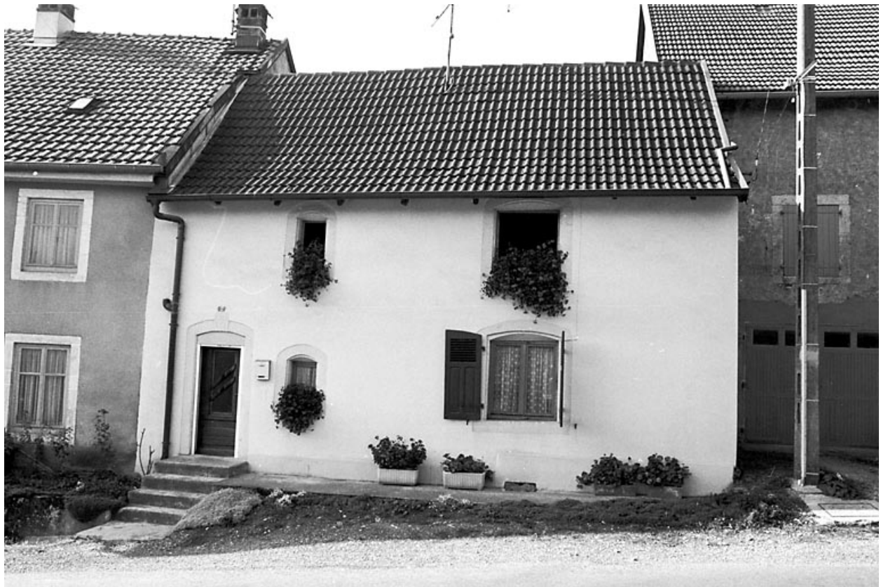
Façade antérieure vue de face.
