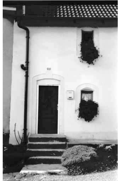
Façade antérieure : détail. Phot. Bernard Lardière IVR43_19832500098Z
