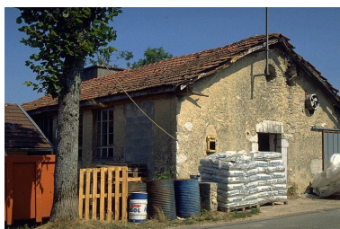
Façade latérale gauche. Phot. Laurent Poupard IVR43_19913901195ZA
