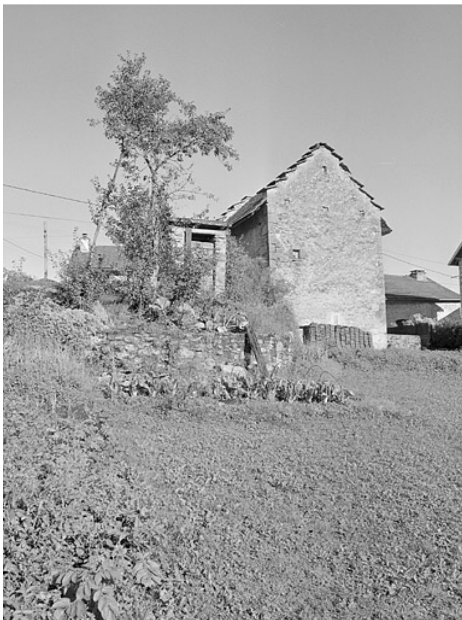
L'ancienne fromagerie de Ponthoux, façade postérieure.
