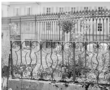
Grilles du jardin potager. Phot. Yves Sancey IVR43_20033900845X
