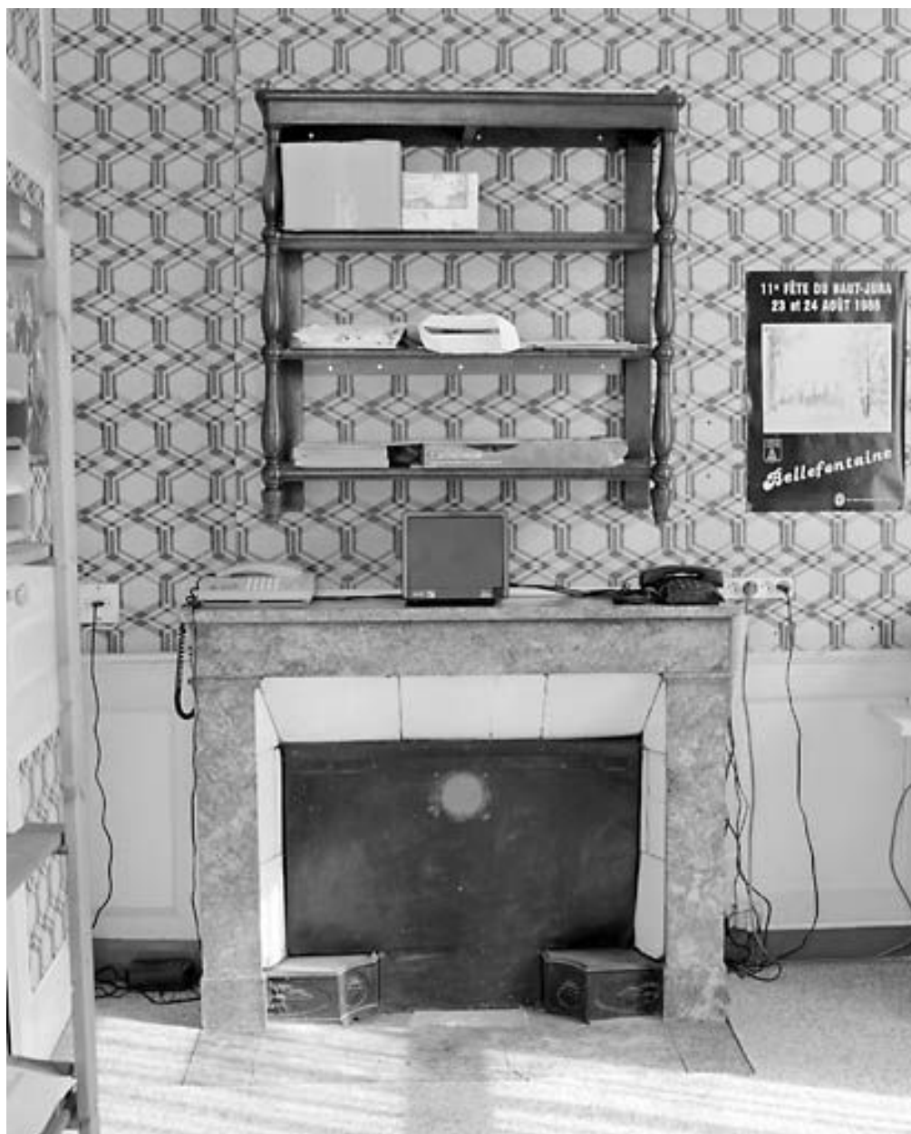
Cheminée en brocatelle, à l'étage.
