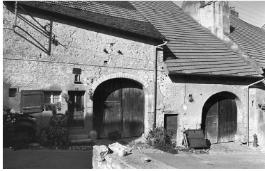
Vue d'ensemble. Phot. Yves Sancey IVR43_19797000390Z
