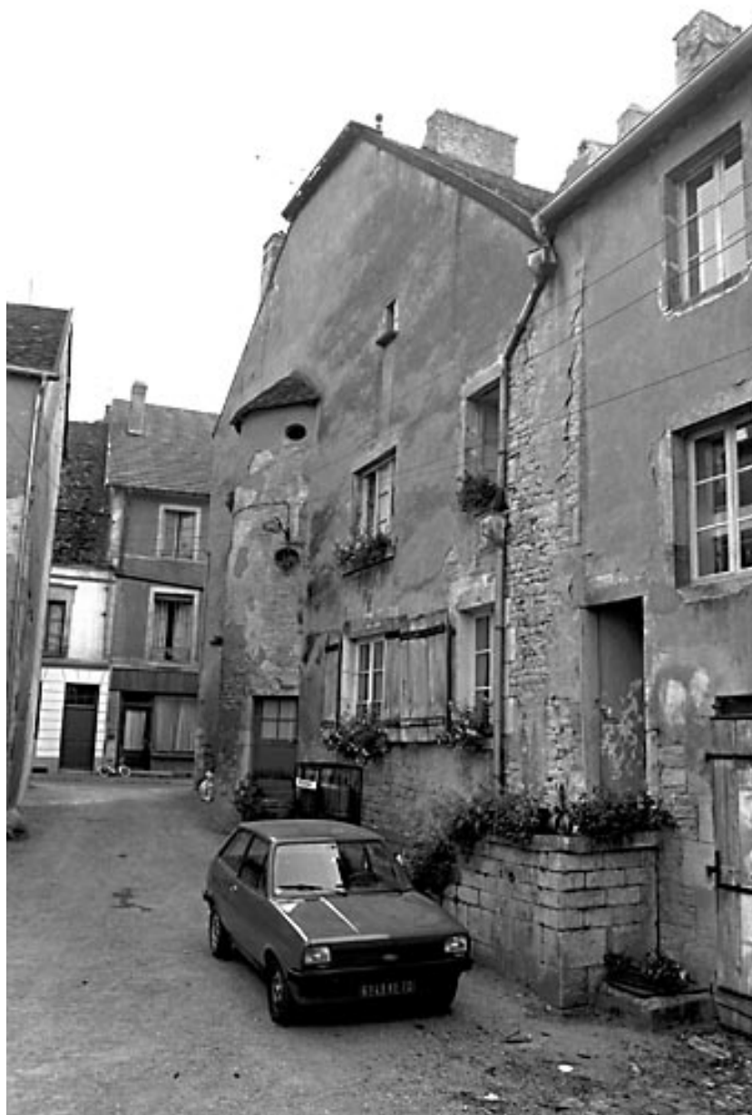
Façade latérale droite sur cour.
