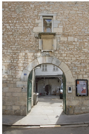
Façade latérale droite : détail du portail d'entrée.
