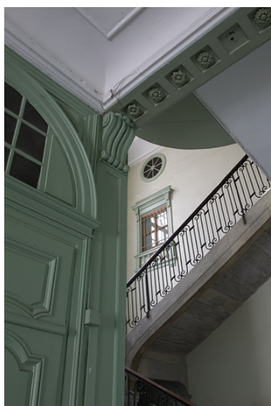
Intérieur, escalier d'honneur : vue depuis le rez-de-chaussée.
