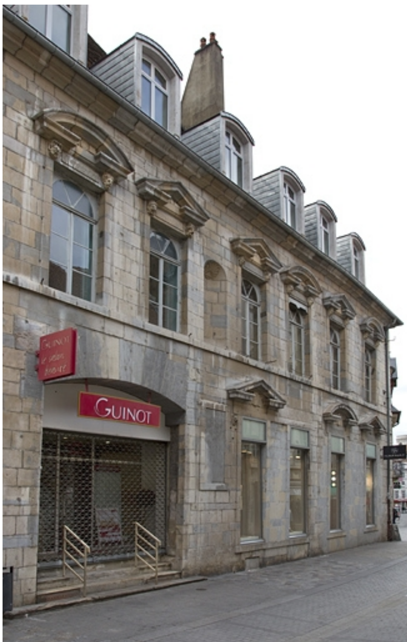
Façade antérieure : détail de la partie droite.
