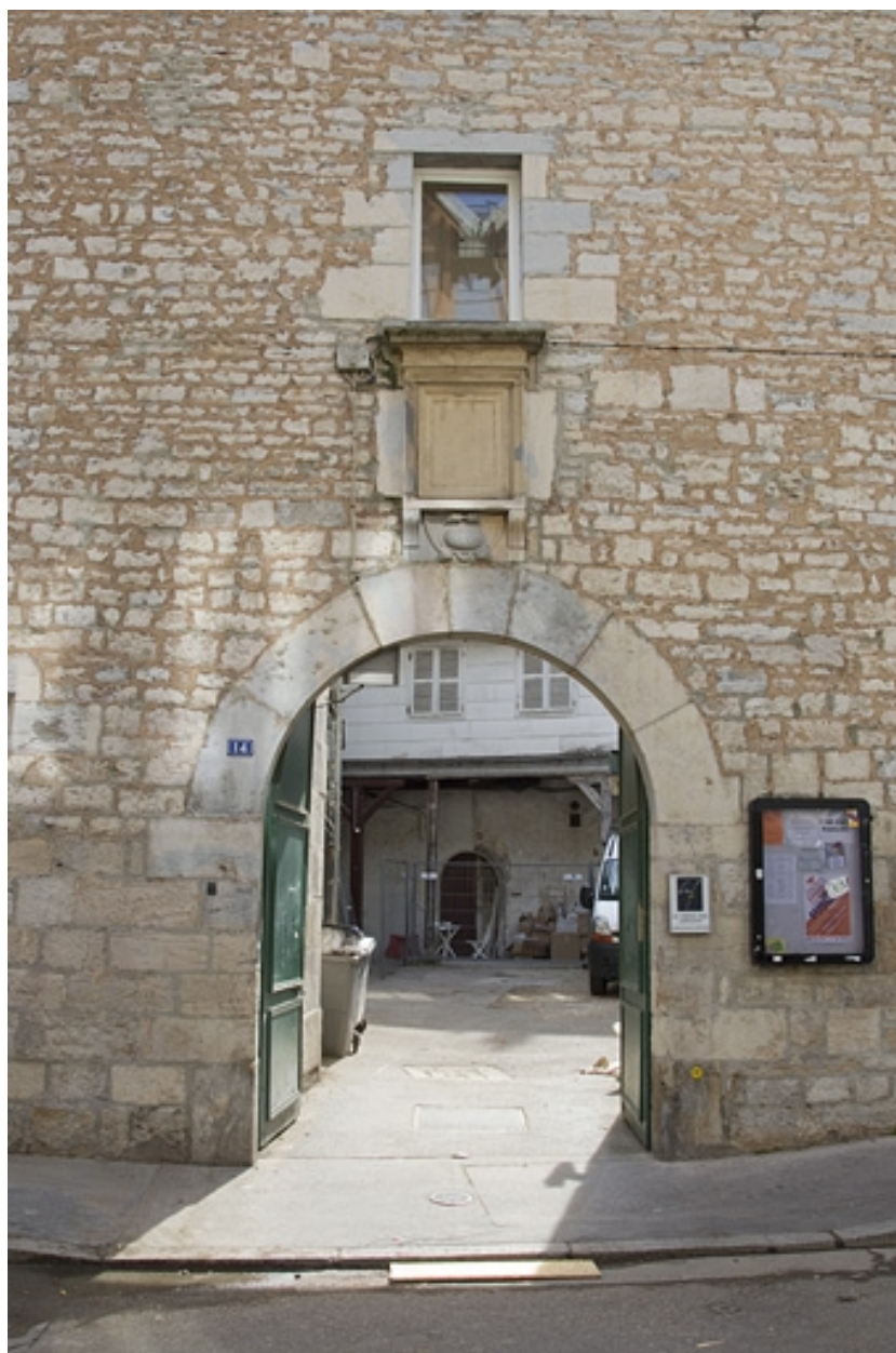
Façade latérale droite : détail du portail d'entrée.
