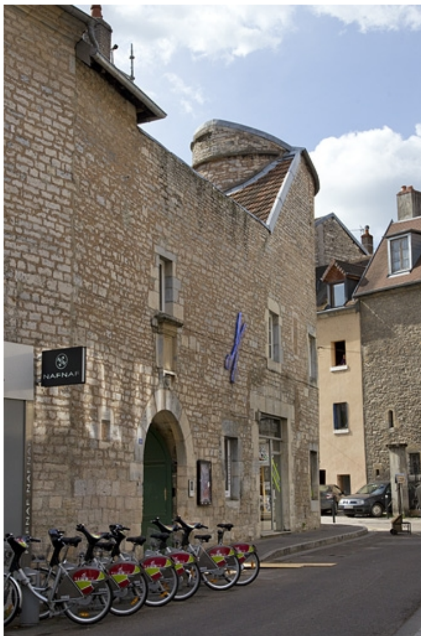
Façade latérale droite : de trois quarts gauche.
