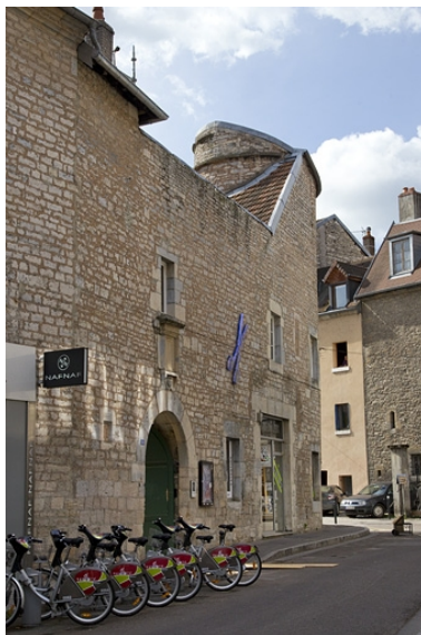
Façade latérale droite : de trois quarts gauche.
