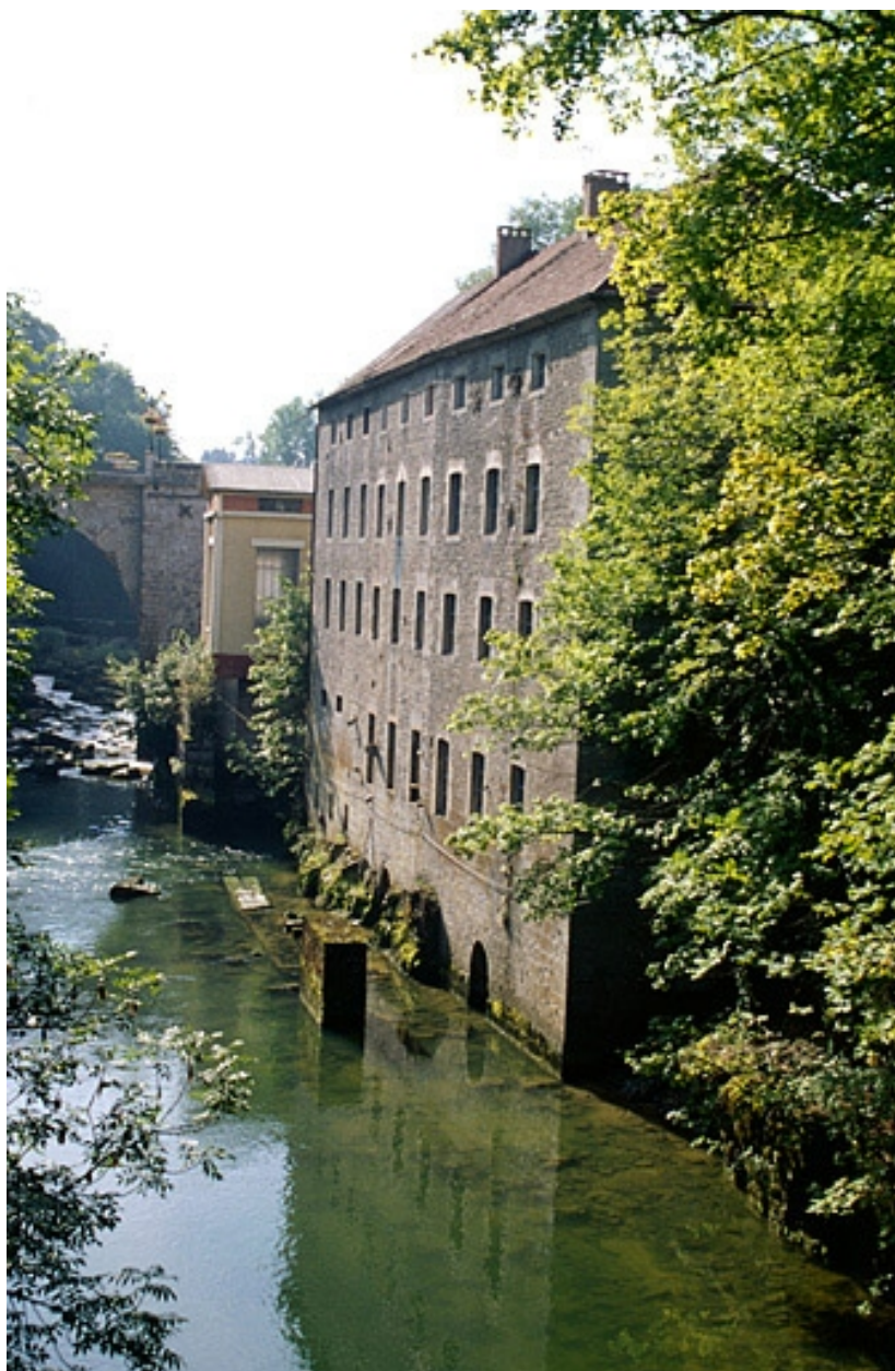
Elévation de l'atelier de fabrication depuis l'aval.
