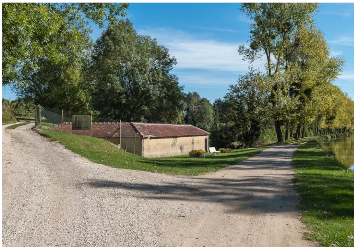
Vue d'ensemble du lavoir.
