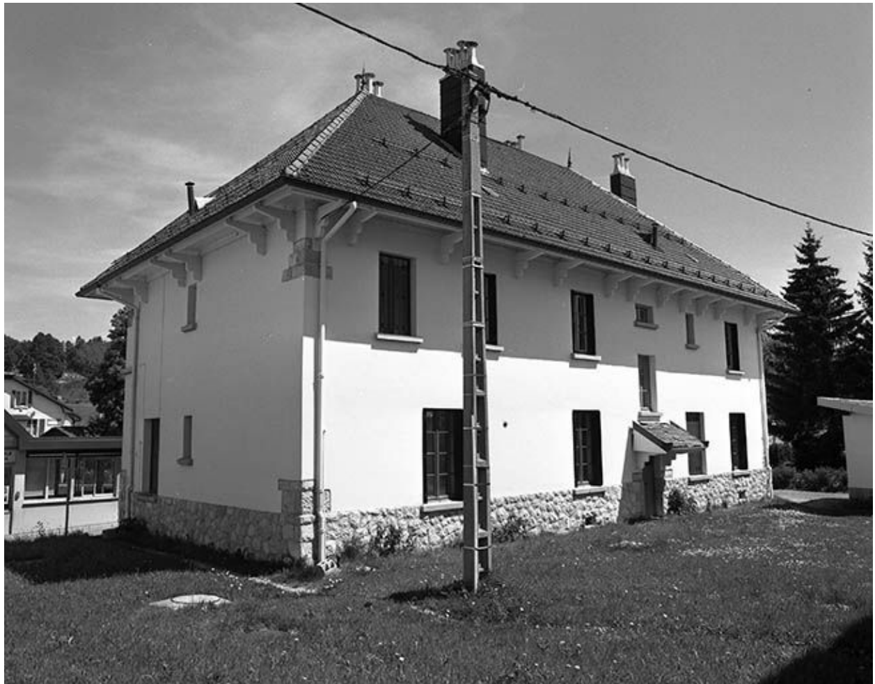
Façade postérieure et face droite.
