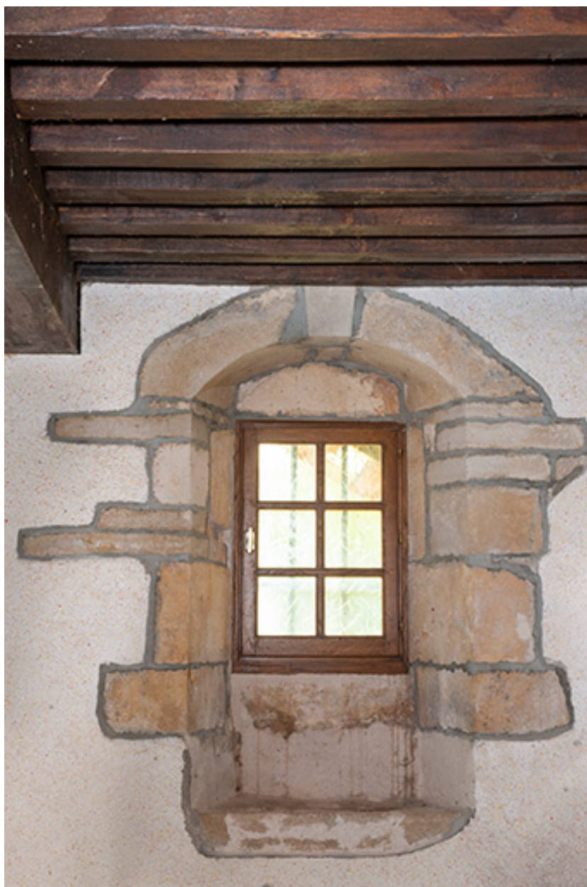
Détail d'une fenêtre, ancienne cure.
