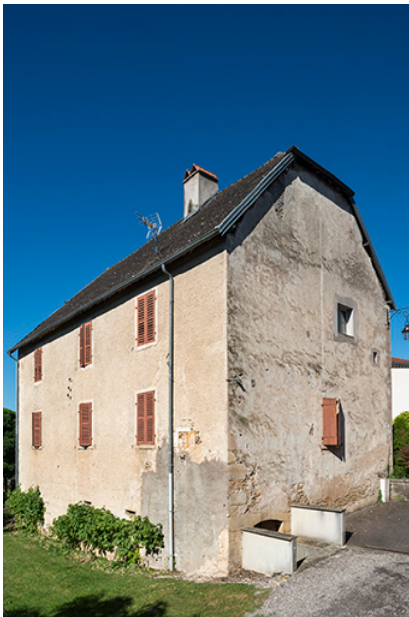
Vue de trois-quarts, façades postérieure et latérale.
