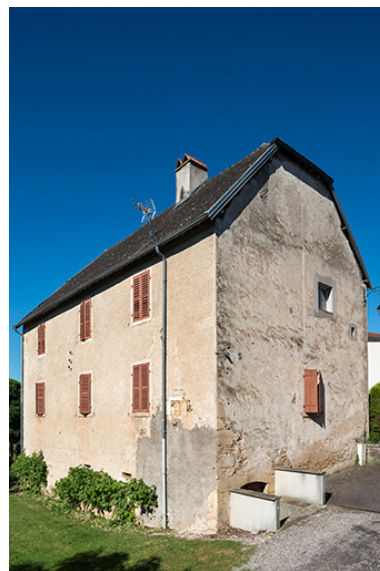
Vue de trois-quarts, façades postérieure et latérale. Phot. Jérôme Mongreville IVR43_20187000373NUC4A
