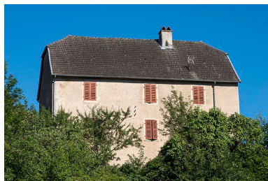
Etages supérieurs de la façade postérieure. Phot. Jérôme Mongreville IVR43_20187000372NUC4A
