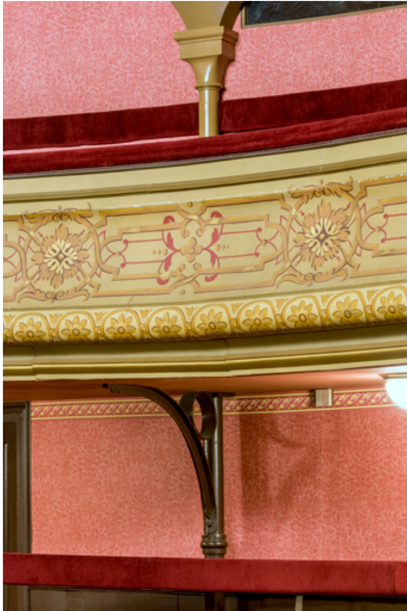
Garde-corps du 3e balcon et poteaux métalliques.
