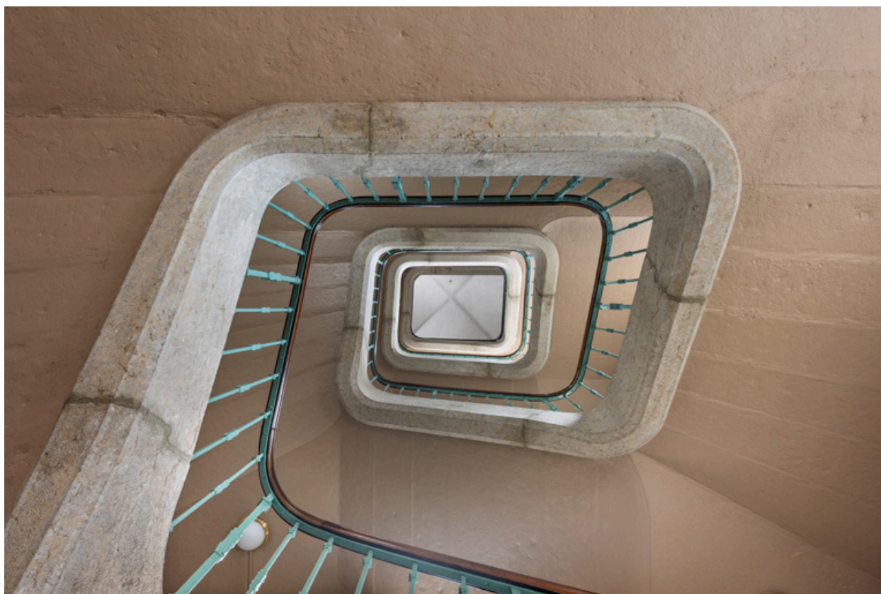
Escalier côté cour, vu en contre-plongée.
