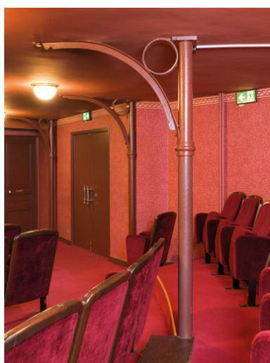
Poteaux métalliques supportant le 1er balcon. Phot. Pierre-Marie Barbe-Richaud IVR26_20257100174NUC4A
