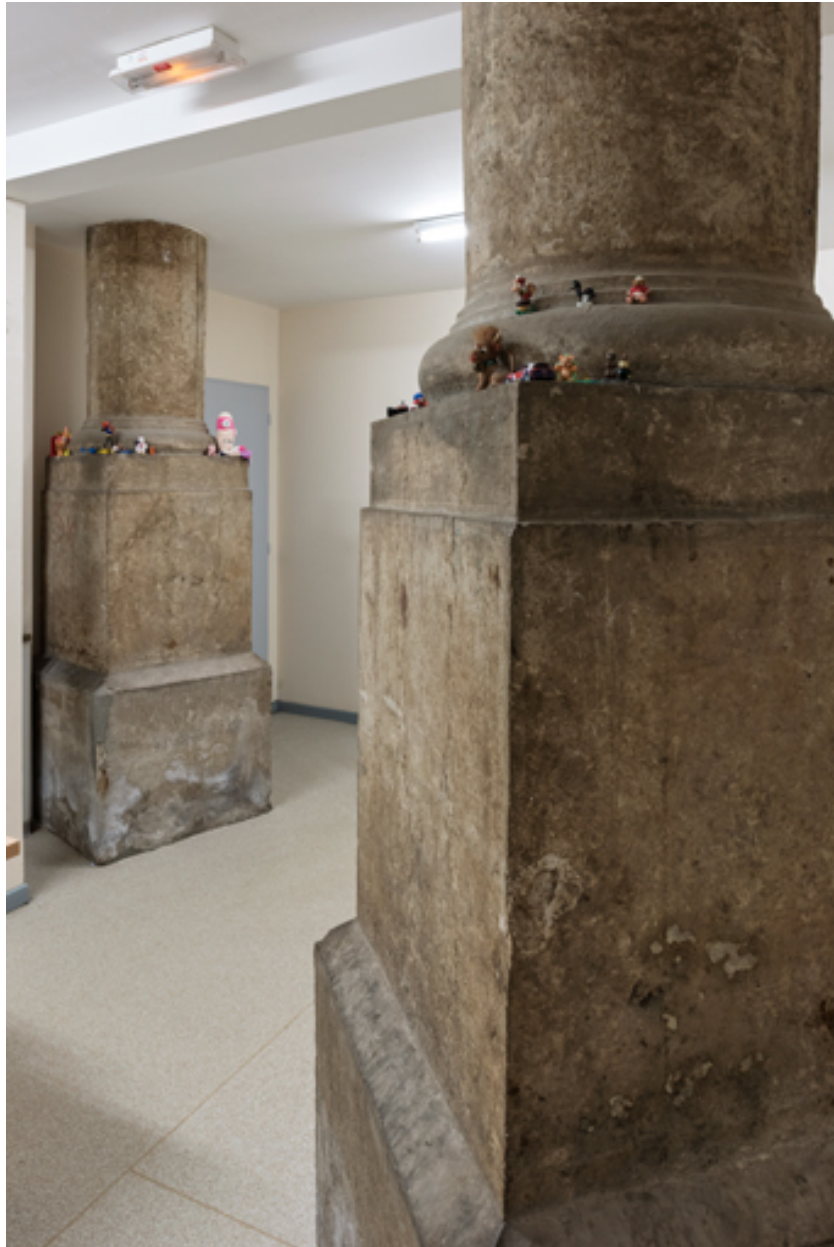
Socle et base de deux colonnes dans l'ancienne halle.
