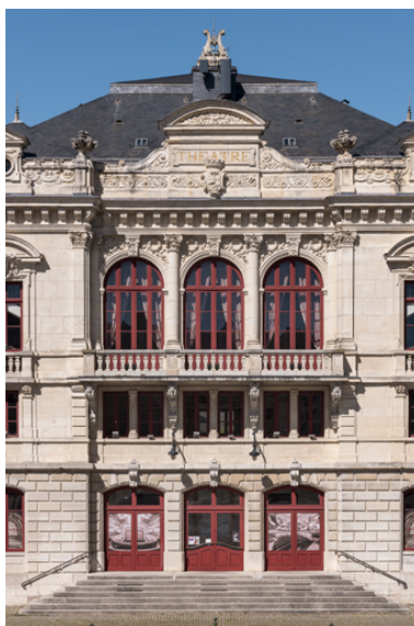
Façade antérieure : travée centrale. Phot. Pierre-Marie Barbe-Richaud IVR26_20257100134NUC4A
