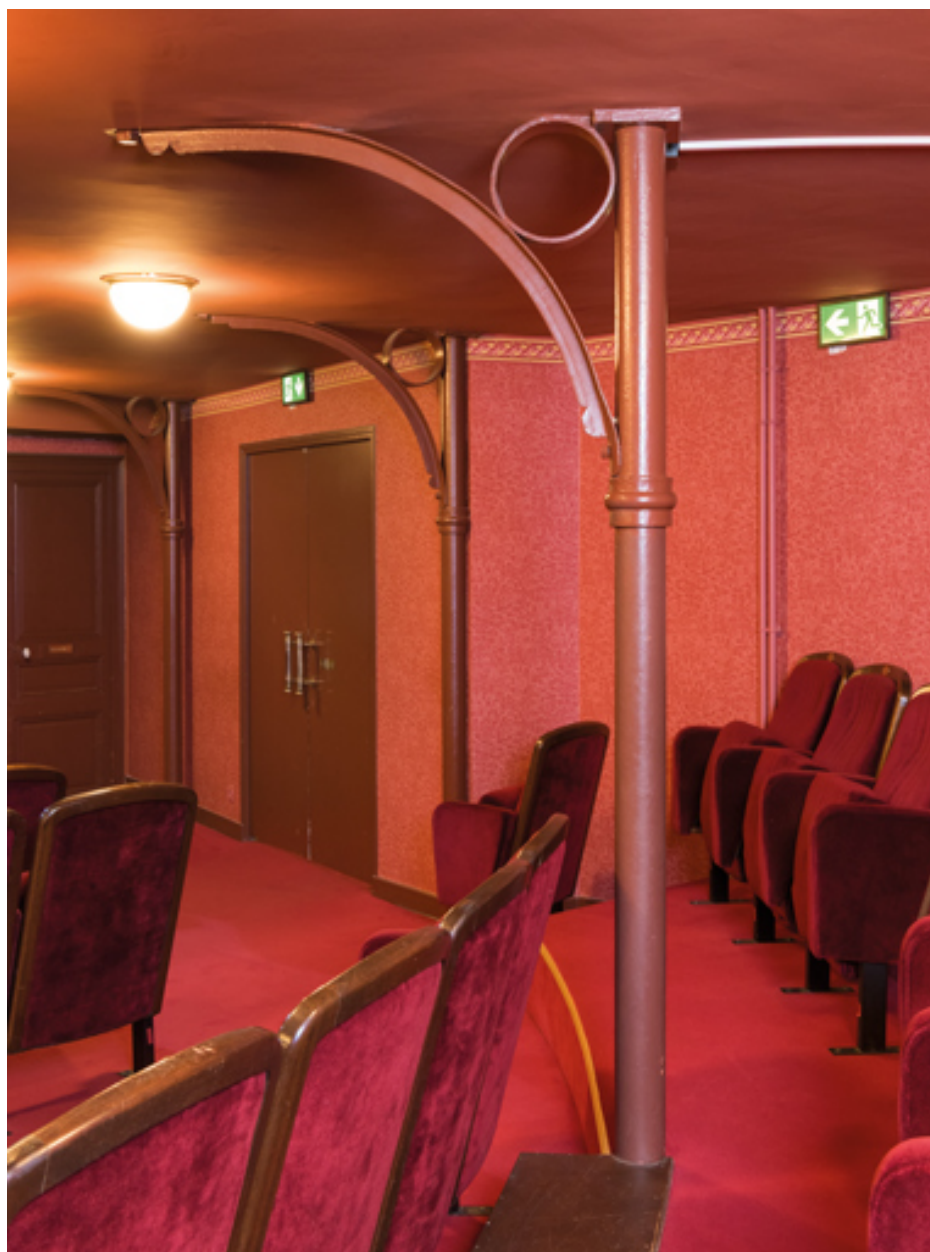
Poteaux métalliques supportant le 1er balcon.
