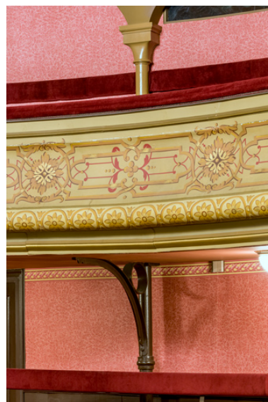
Garde-corps du 3e balcon et poteaux métalliques. Phot. Pierre-Marie Barbe-Richaud IVR26_20257100231NUC4A
