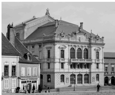
[Théâtre et hôtel de ville, depuis le sud : détail du théâtre]. S.d. [4e quart 19e siècle, entre 1884 et 1900].
