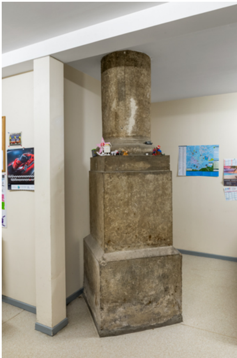
Socle et base d'une colonne dans l'ancienne halle.
