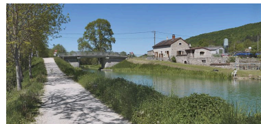
Maison de garde prise d'amont.
